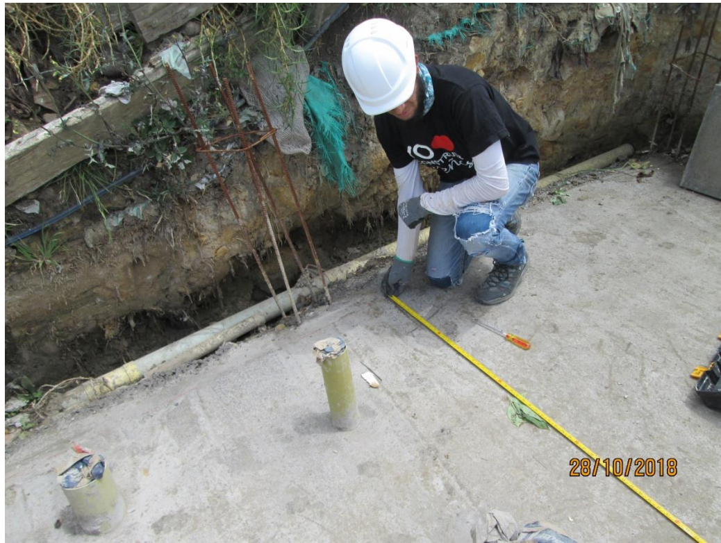
Figura 57. Replanteo realizado por el coordinador de montaje Fuente: Elaboración propia.
