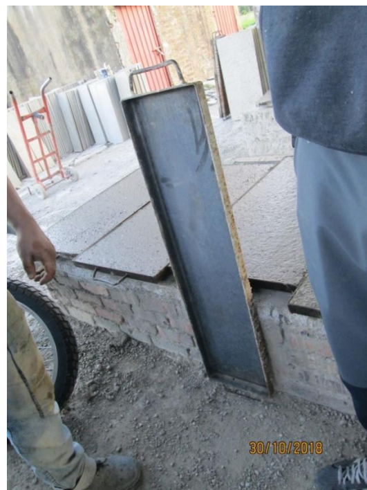
Figura 33. Formaleta 2-8 limpia. Elaboración propia.
