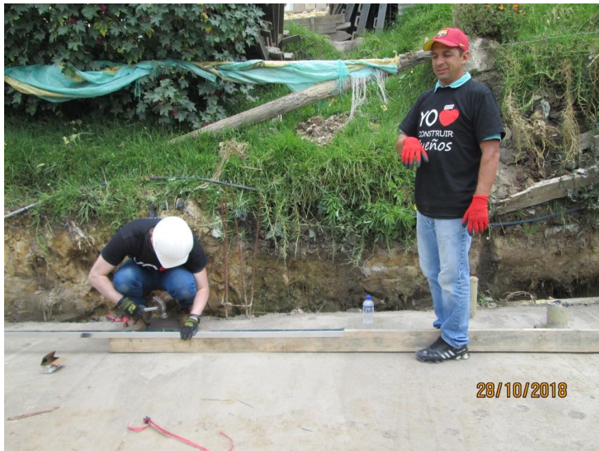
Figura 62. Elaboración de media correa. Fuente: Elaboración propia.
