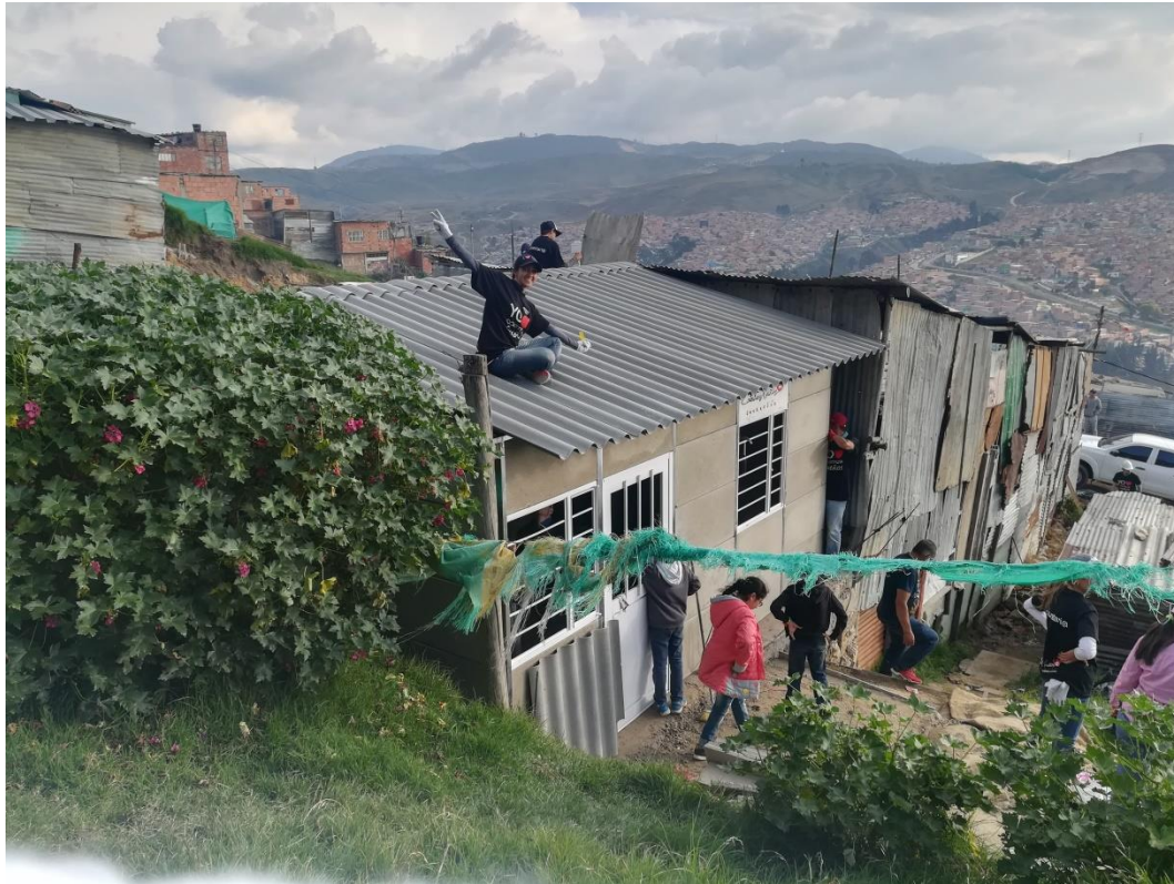
Figura 82. Casa prefabricada terminada Fuente: Elaboración propia.
