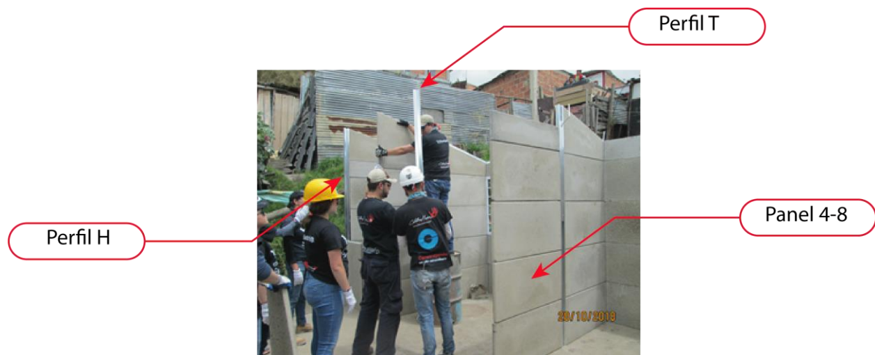
Figura 74. Montaje de segunda hilera de muros Fuente: Elaboración propia.
