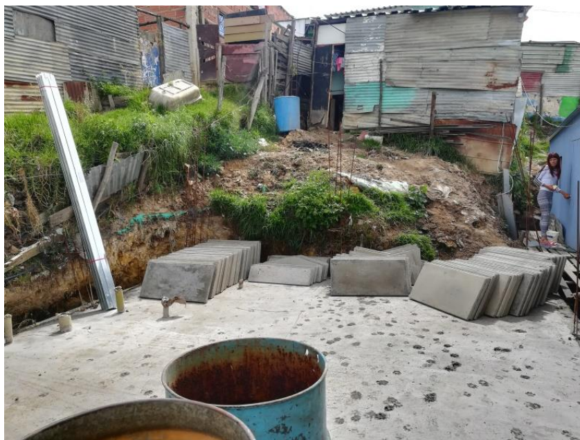
Figura 52. Componentes de vivienda, perfiles, paneles en concreto y Barril metálico. Fuente: Elaboración propia.
