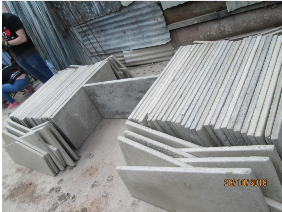
Figura 65. Paneles ordenados en forma de "I" Fuente: Elaboración propia.
