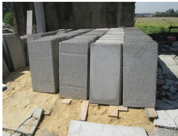
Figura 43. Apilamiento de paneles en concreto. Fuente: Elaboración propia.
