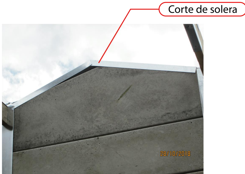
Figura 60. Solera panel C3 lista para ser instalada. Fuente: Elaboración propia.
