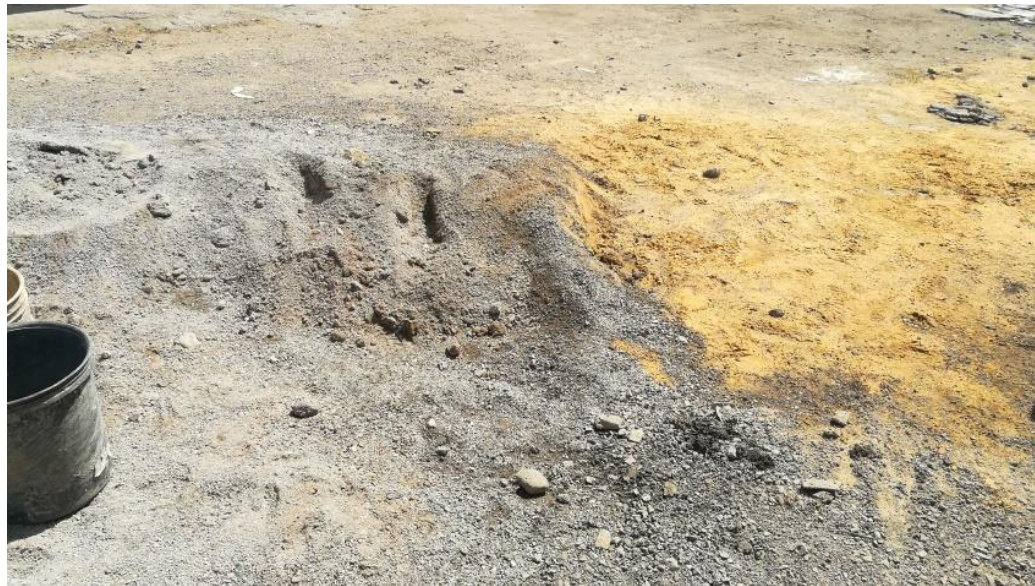
Figura 27. Arena. Almacenamiento de arena reciclada de obra Elaboración propia.
