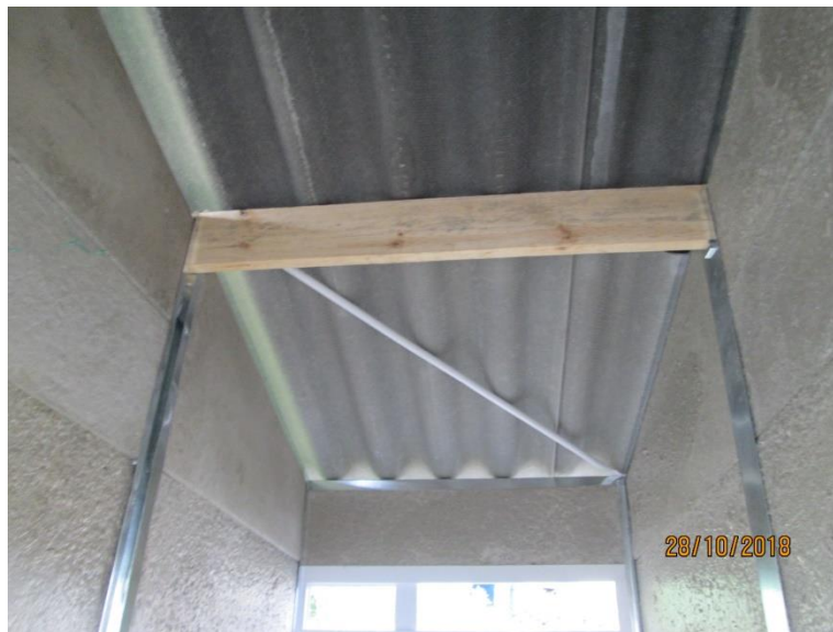
Figura 80. Riostras instaladas. Fuente: Elaboración propia
