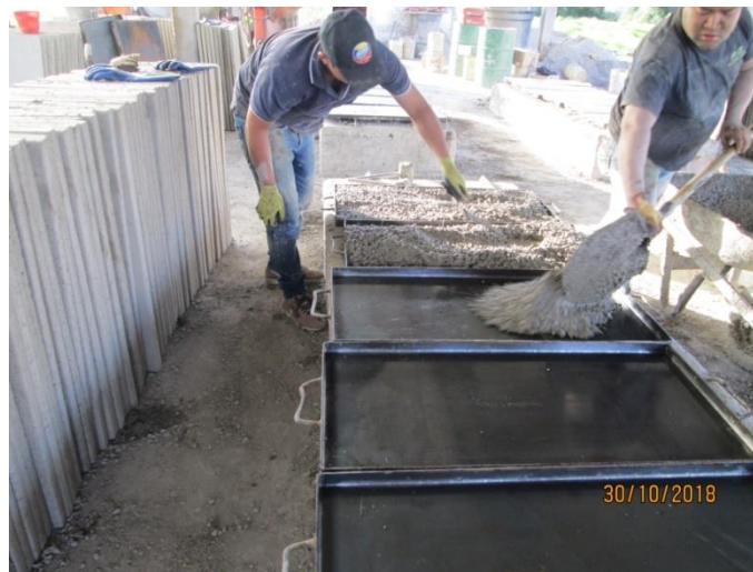
Figura 38. Vaciado del concreto en formaletas Fuente: Elaboración propia.
