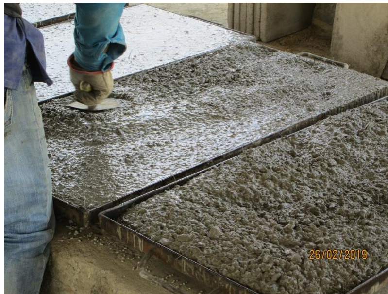
Figura 39. Esparcimiento del concreto de forma manual. Fuente: Elaboración propia.
