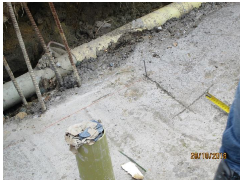
Figura 58. Losa cimbrada. Fuente: Elaboración propia.
