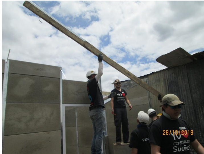
Figura 73. Izaje de correa de manera manual. Fuente: Elaboración propia.
