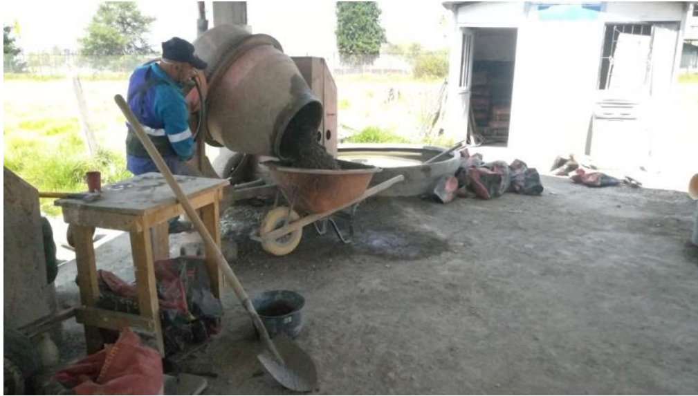
Figura 37. Depósito de concreto en carretilla. Fuente: Elaboración propia.
