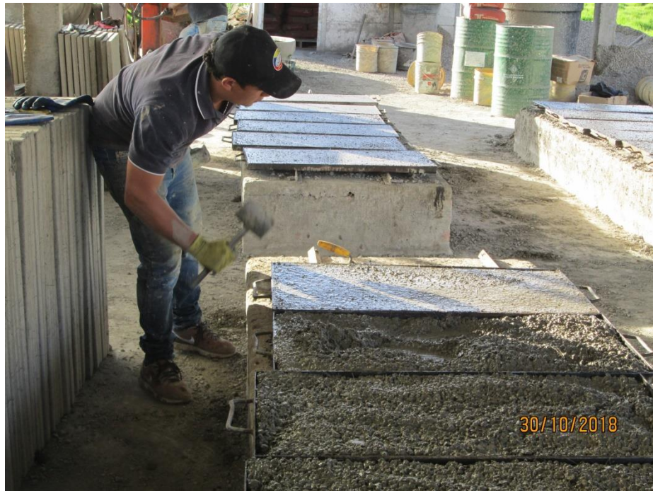
Figura 40. Vibrado del concreto mediante Martillo de goma Fuente: Elaboración propia.
