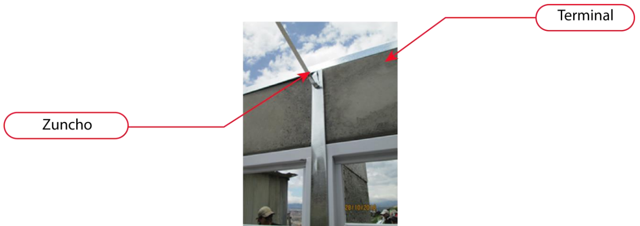
Figura 70. Zunchos previos a realizar el amarre. Fuente: Elaboración propia.
