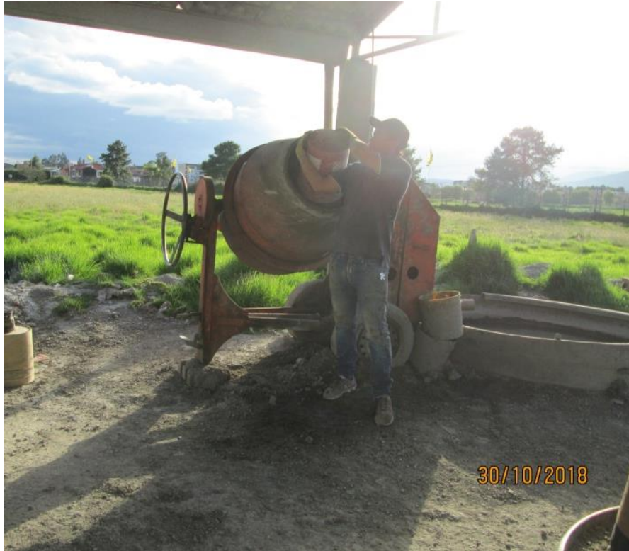
Figura 30. Vaciado de cemento Elaboración propia.
