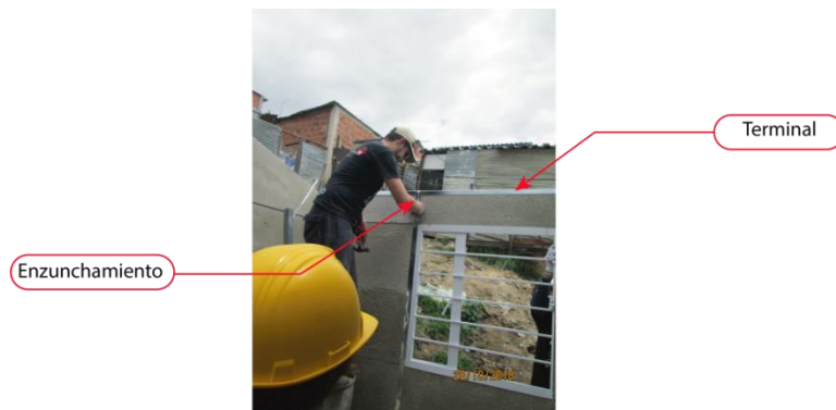
Figura 71. Enzunchamiento Fuente: Elaboración propia.
