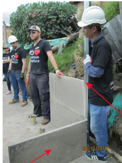
Figura 65. Paneles ordenados en forma de "I" Fuente: Elaboración propia.
