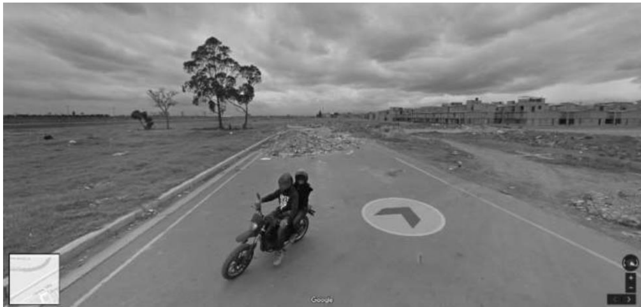
Figura 19. Final de la ALO en Bosa. Deterioro actual de la vía.
