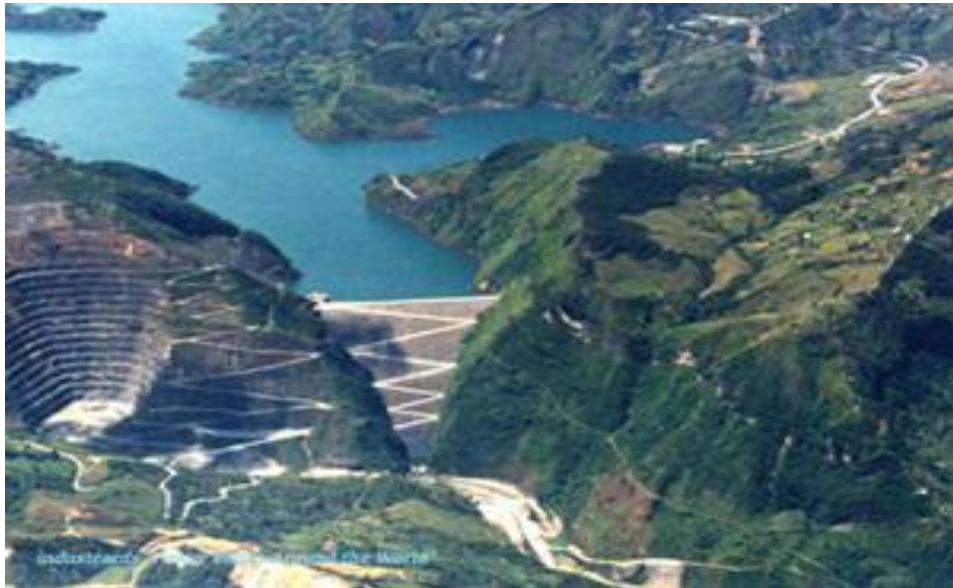
Figura 7: Hidroeléctrica del Guavio
