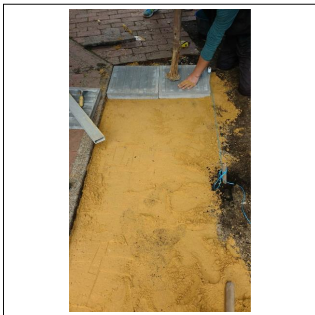
Ilustración 14: instalación de losetas en concreto sobre base en arena
