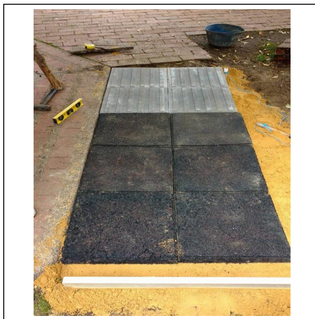
Ilustración 15: instalación de losetas de concreto y caucho
