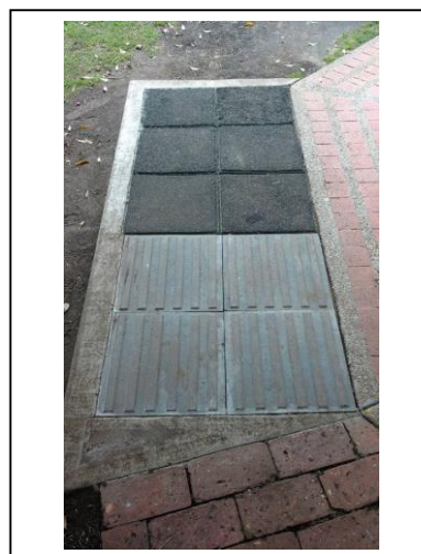
Ilustración 18: tramo de prueba
