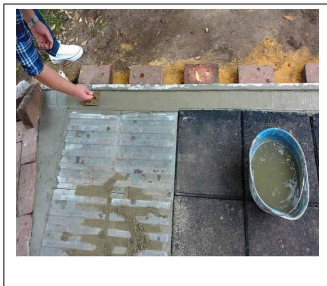
Ilustración 16: proceso de bocelado para acabado en concreto
