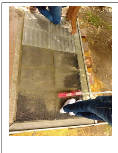
Ilustración 20: emboquillaje de tramo de prueba.
