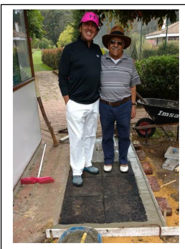
Ilustración 19: tramo de prueba terminado
