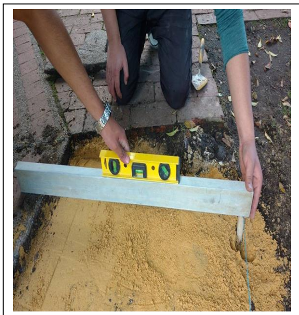
Ilustración 13: nivelación de base en arena
