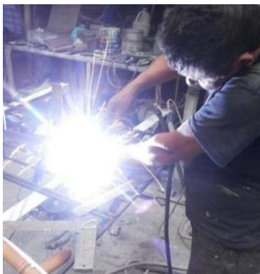
Imagen 28. Soldadura de platinas.
