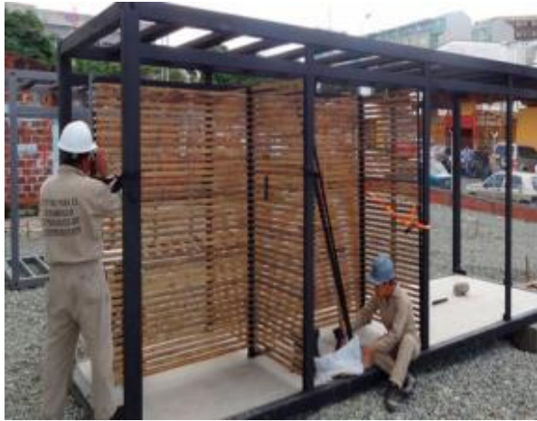
Imagen 2. Instalación del módulo. (2013)
