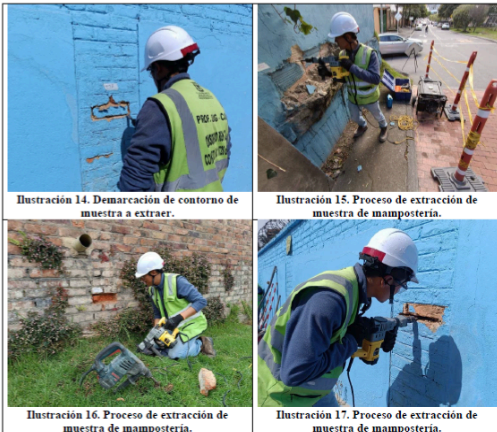
Ilustración 39 Proceso de extracción de muestras de mampostería
