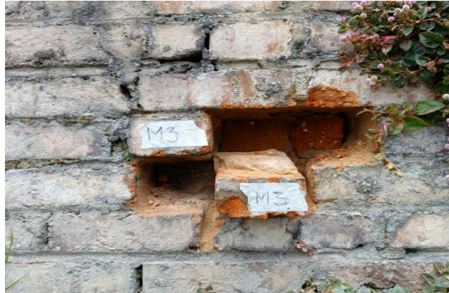
Ilustración 42 Muestra de mampostería extraída N° 3
