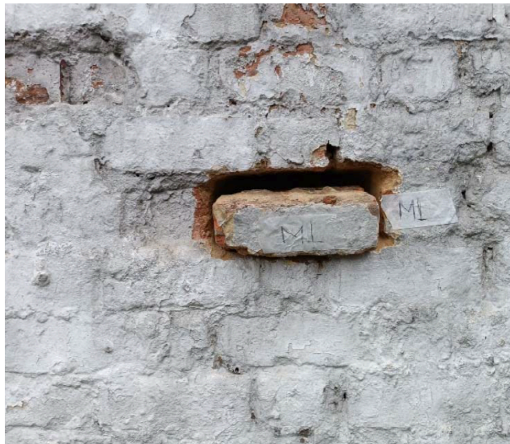
Ilustración 40 Muestra de mampostería extraída N° 1
