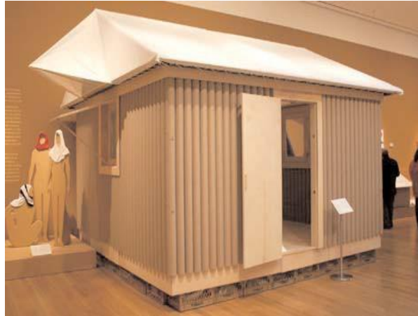
Figura 9: Vivienda de emergencia en tubos de cartón
