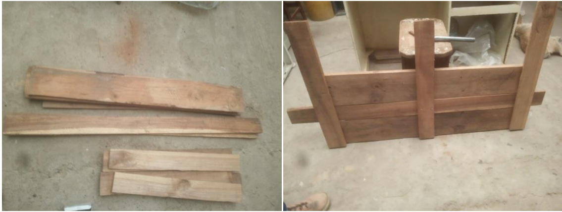
Figura 2. Maderos y unión de la primera sección del encofrado. Elaboración propia.
