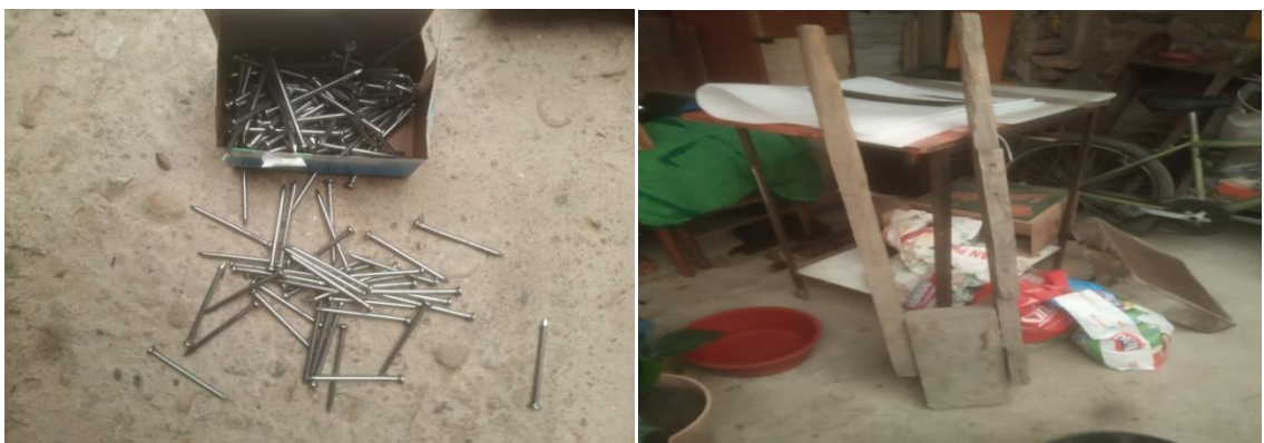
Figura 3. Segunda etapa de madero y finalización de encofrado de madera. Elaboración propia.
