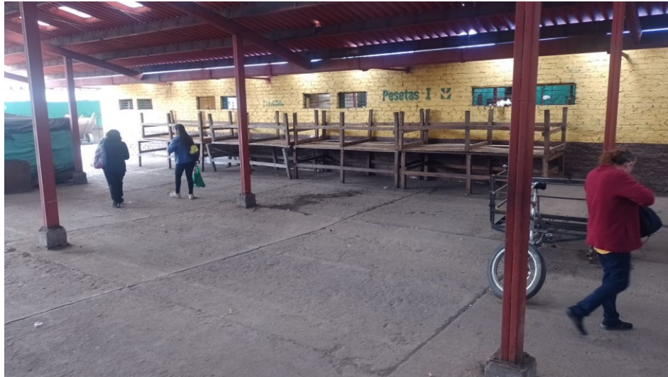
Figura 18 Evidencia de puestos en desuso.
