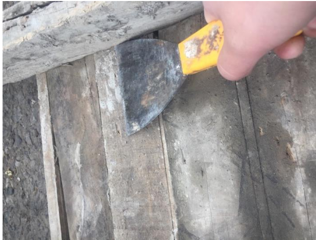
Figura 13 Limpieza de madera
