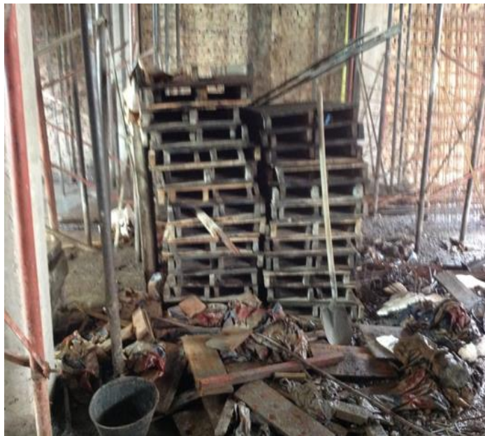
Figura 5 Almacenamiento de formaleta tradicional
