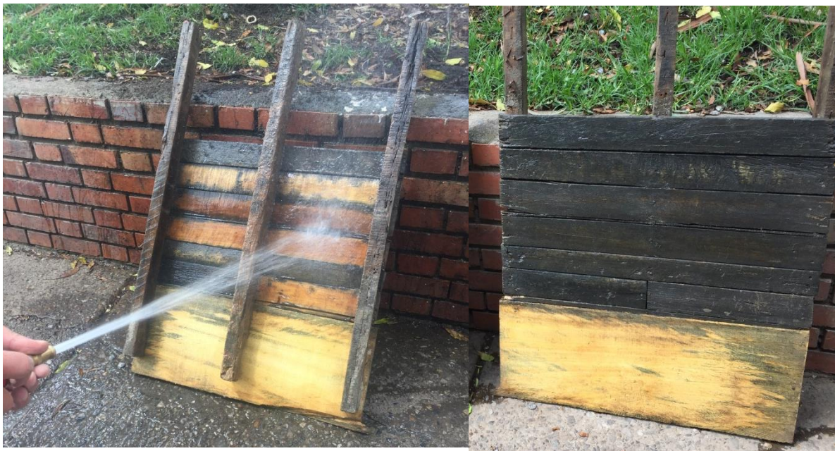
Figura 15 Lavado a presión
