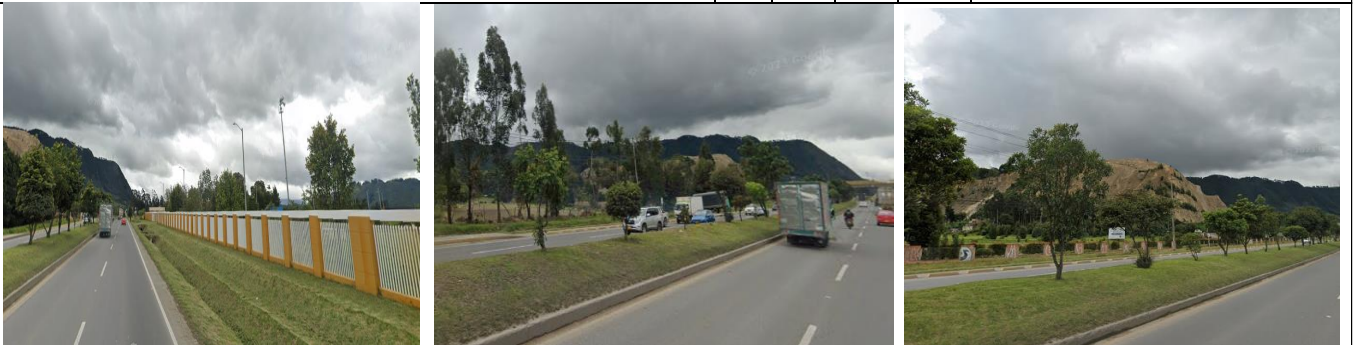
Pie de foto: se muestra la composición de la vía y el bordillo existente en el separador central.
