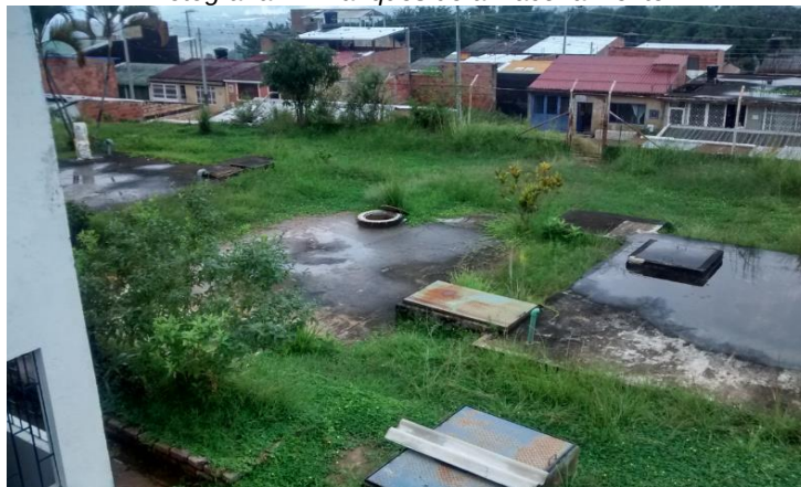
Fotografía 17. Tanques de almacenamiento
