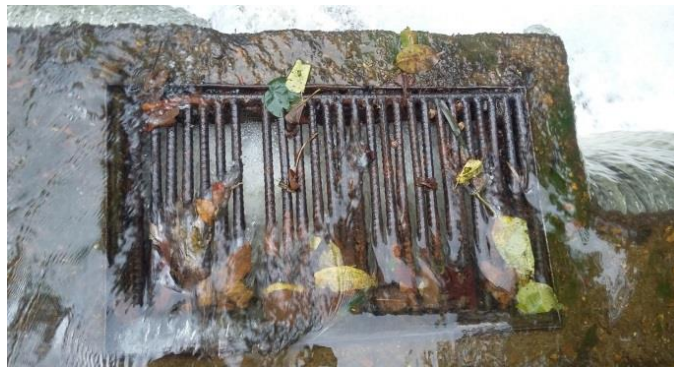
Fotografía 5. Ausencia de varillas en rejillas
