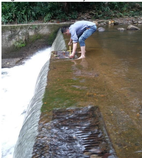
Fotografía 3. Medición de rejillas en la bocatoma.
