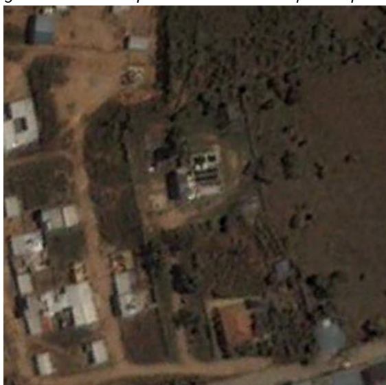
Fotografía 1. Imagen satelital de la planta de tratamiento para la potabilización de agua
