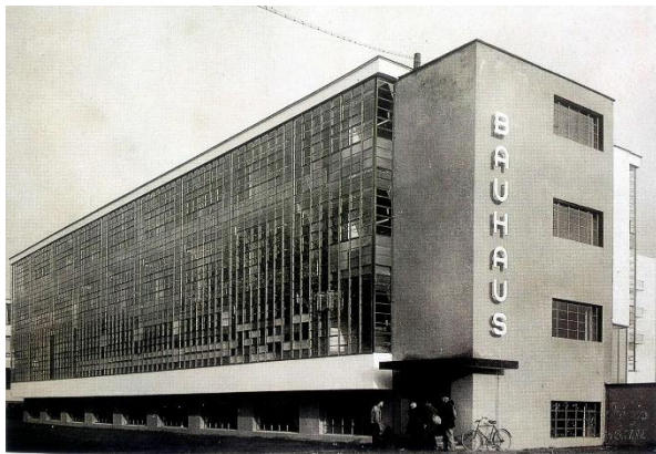
Imagen 1: Edificio Bauhaus (fachada principal)
