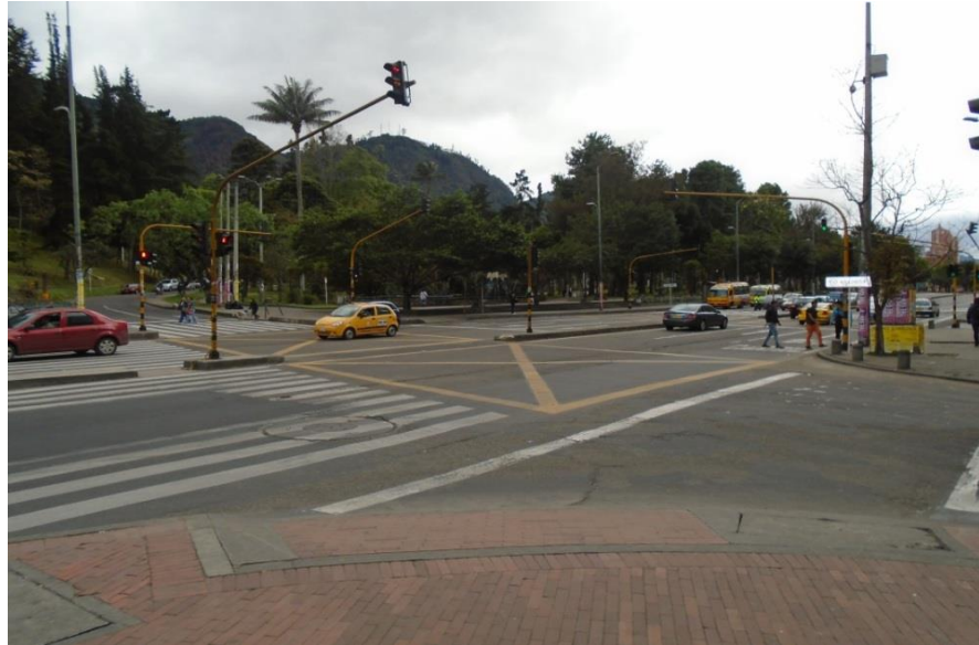
Anexo 2. Evidencia fotográfica de la intersección de la carrera 7ª por calle 39.
