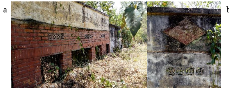
Figura 1. a. Arquitectura en ladrillo, b. detalle celosía y zócalo. (Elaboración propia)
