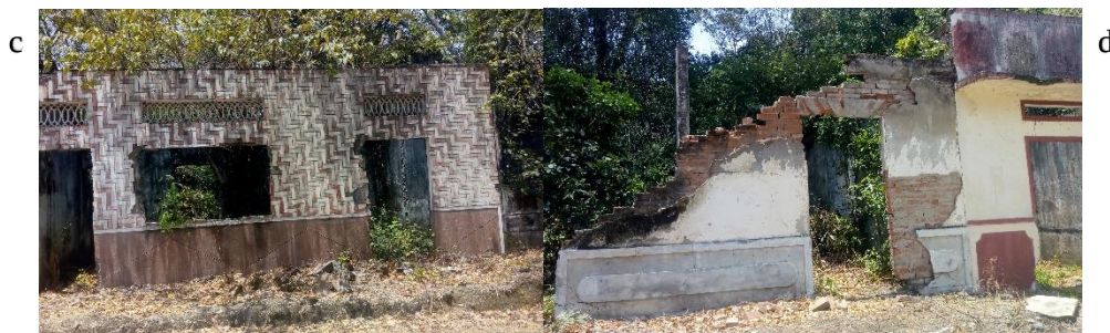
Figura 2. c. uso de diferentes tipos de acabados, d. métodos constructivos. (Elaboración propia)
