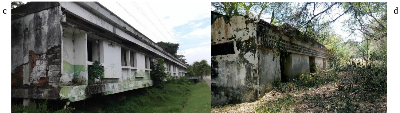
Figura 4. c. Hospital San Lorenzo situación actual, d. Hospital San Lorenzo bloque posterior situación actual.
