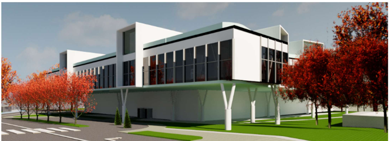
Figura 41 Vista Peatonal, Configuración Formal de la Fachada
