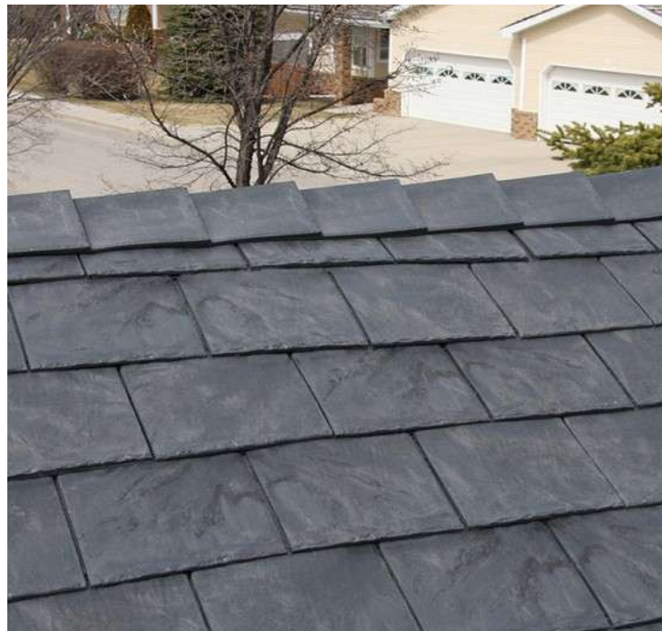
Ilustración 5 Tejado con llantas usadas
