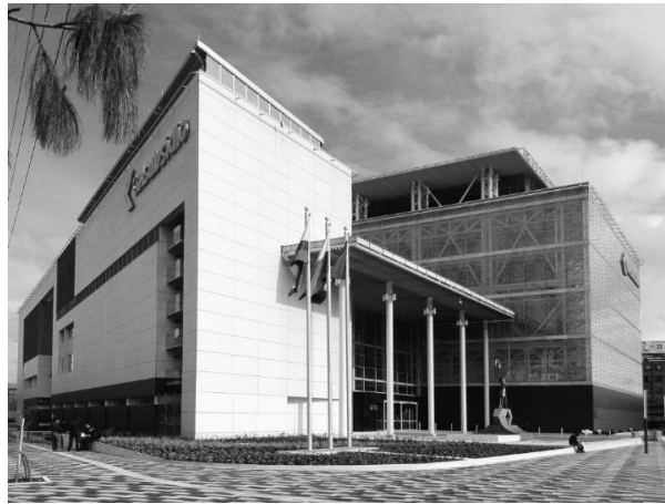
Figura 6. Vista exterior del equipamiento “El Cubo”. Fotografía por: Edgar Solano, tomado de: Arch Daily
