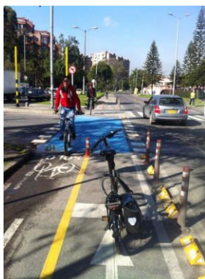
Figura 1: Cicloruta sobre calzada – Avenida carrera 50
