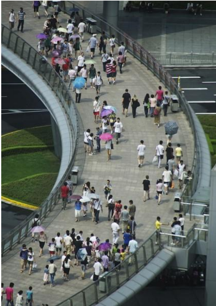
Figura 12 Foto paso peatonal de la rotonda. Fuente: Viktor Lakics
