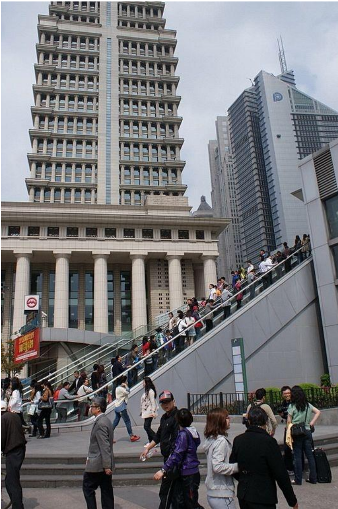
Figura 11 Foto escaleras eléctricas rotonda. Fuente: Viktor Lakics
