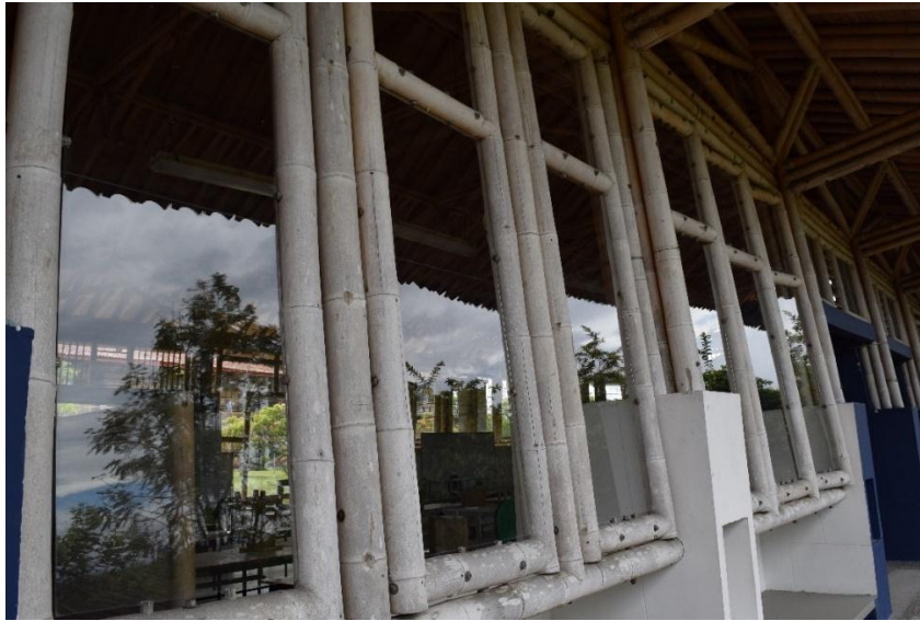
Imagen 54 Fachada Laboratorio de Arquitectura (Seccional Armenia-UGC)
