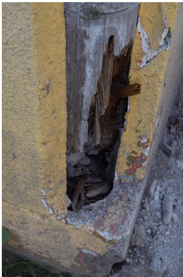
Imagen 63 Columna de Guadua atacada por insectos.
