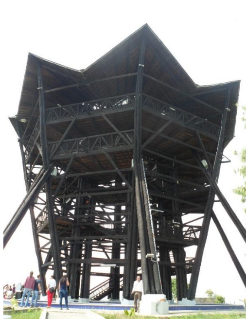
Imagen 52 Estructura en madera, Ecoparque Mirador Colina Iluminada
