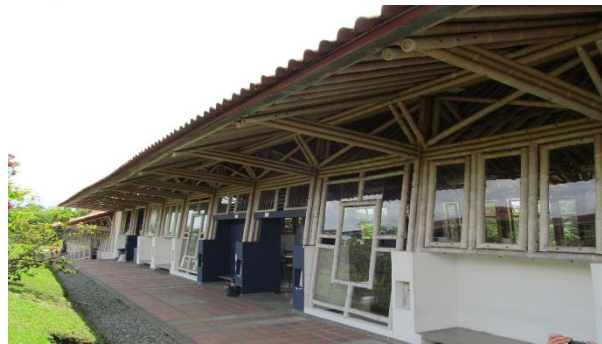
Imagen 12.Estructura de Guadua de la Universidad La Gran Colombia en La sede de Armenia.
