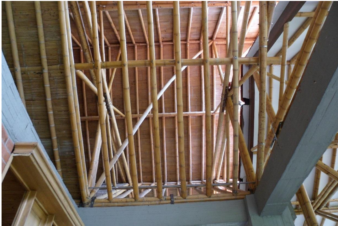
Imagen 9. Elemento estructural sometido a flexión por cargas (UGC- Sede Armenia)
