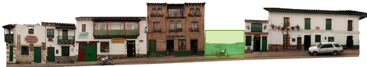
Imagen 24. pérdida de BIC. perfil septiembre de 2017 vs fotografía del predio tomada en abril de 2017, fuente propia.
