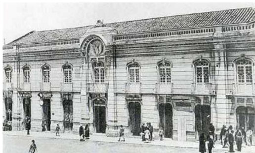
imagen ¡Error! No hay texto con el estilo especificado en el documento.-2 Edificio casa Tunja/ demolido por orden del General Gustavo rojas pinilla
