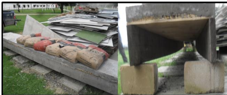
Fig.32: Carga de cemento de 300kg cada uno aún no se presenta ninguna deformación Fuente: Elaboración propia (2017).
