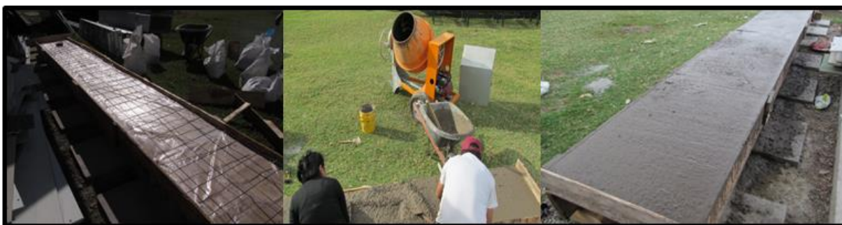
Fig.29: Curado de concreto, se esperó de 28 días para para su mayor resistencia Fuente: Elaboración propia (2017).
