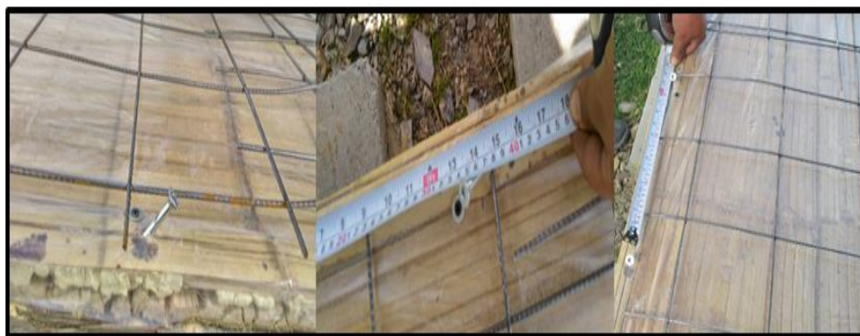
Fig.28: Conectores tirafondo de acero al carbón de 3" a una distancia de 35 cm en un ángulo de 45°, para una mayor sección del conector cuya dimisión es de 5.32* 0.61 metros. Fuente: Elaboración propia (2017).
