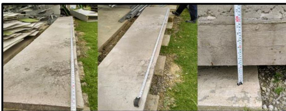
Fig.30: Entrepiso de guadua laminada macana, conector de acero al carbón de 3", concreto a su mayor resistencia, medida total de entrepiso 5.32 metros, altura de 11 cm del suelo a la viga. Fuente: Elaboración propia (2017).
