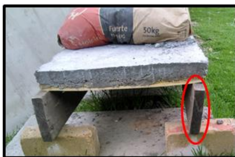
Fig.35: Se evidencia un pandeo lateral de la viga por el peso de 600 kg que está sosteniendo el entrepiso
