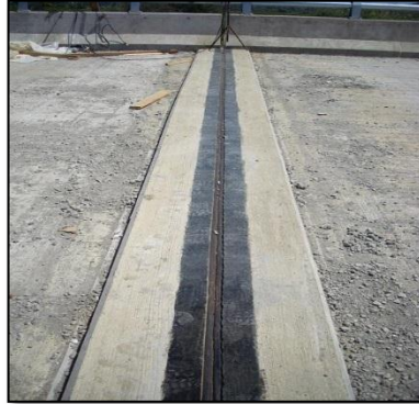
Figura 8. Sellante Preformado.
