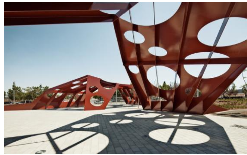
Gráfico 27 Estructura de las pérgolas. Fuente Jordi Surroca.
