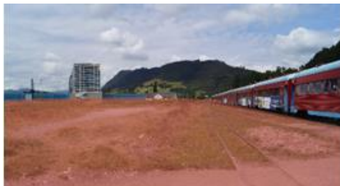
Gráfico 1 Deterioro de la entrada principal. Elaboración propia.
