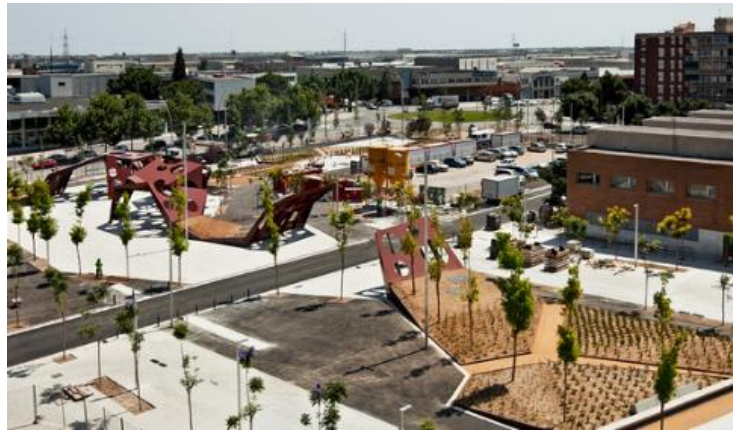
Gráfico 25 Estructura Multifuncional en el Sector del Saló / Batlle i Roig Arquitectes. Fuente Jordi Surroca.
