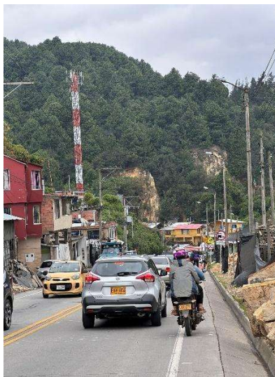
Figura 37. Tramo 3 antes de la intervención. Ausencia de espacio público, alta velocidad y riesgo. Elaboración propia
