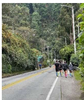
Figura 31. Tramo 1 antes de la intervención. Congestión modal, inexistencia de andenes y riesgo por superposición de flujos. Elaboración propia
