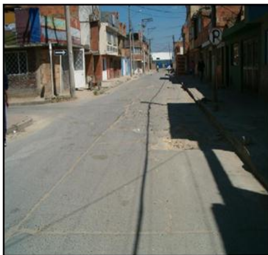
Fotografía No 8: Carrera 77 J Bis por Calle 65 J Sur
