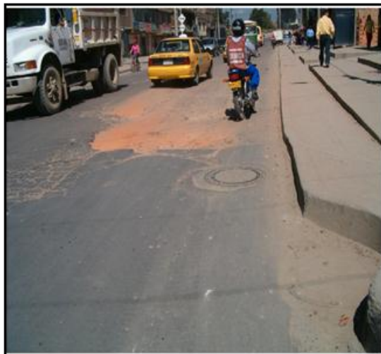
Fotografía No 7: Carrera 77 K por Calle 65 J Sur
