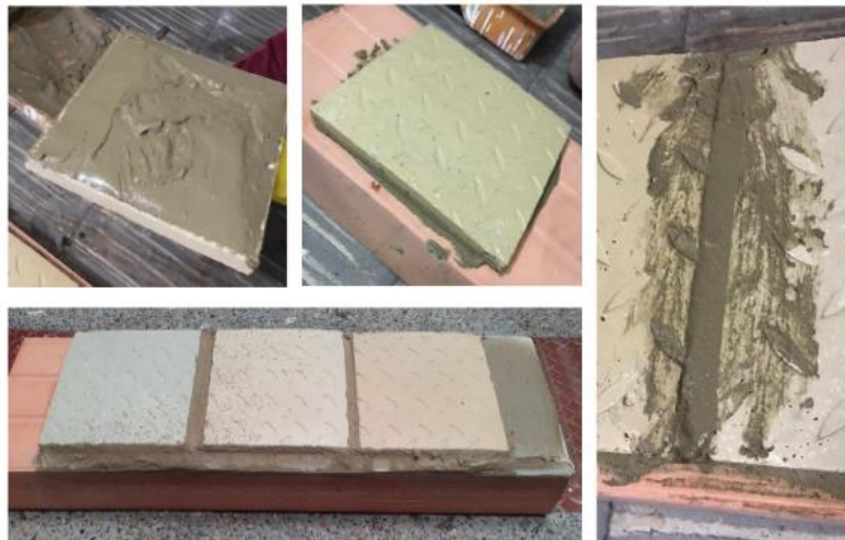
Figura 34 Instalación Prototipo Elaboración propia
