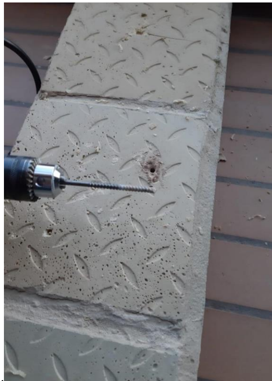
Figura 33 Perforaciones en tabletas Elaboración propia
