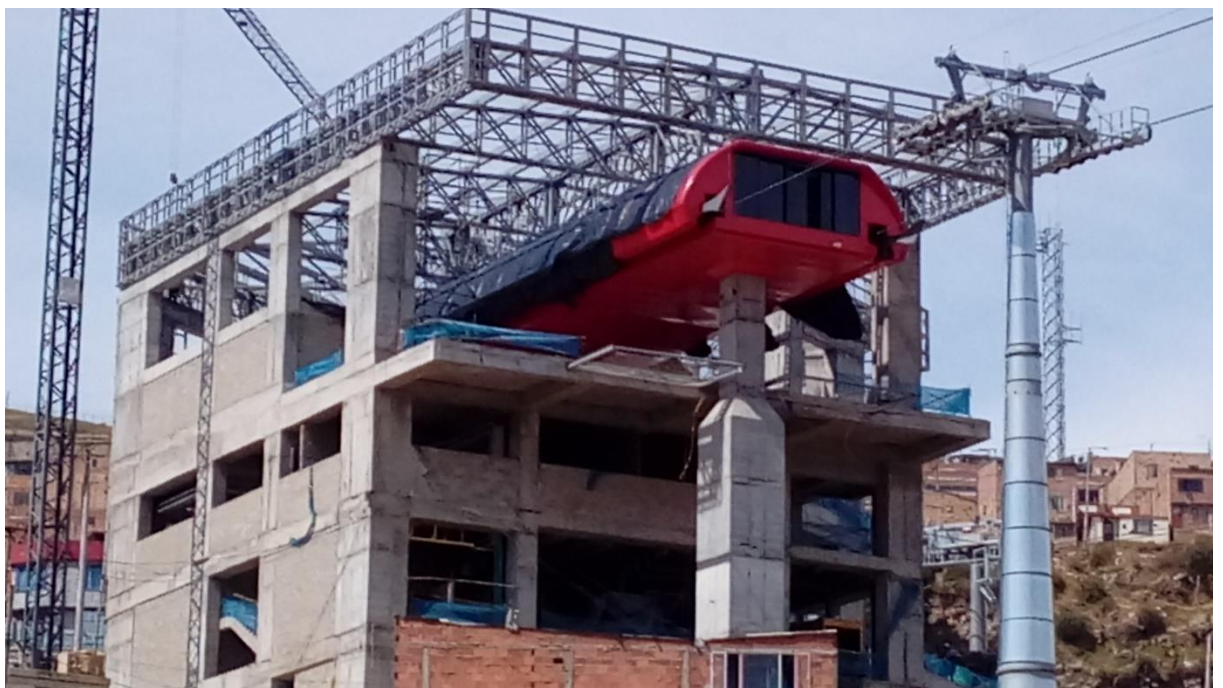
Imagen 5: Estación Manitas Transmicable (foto propia)
