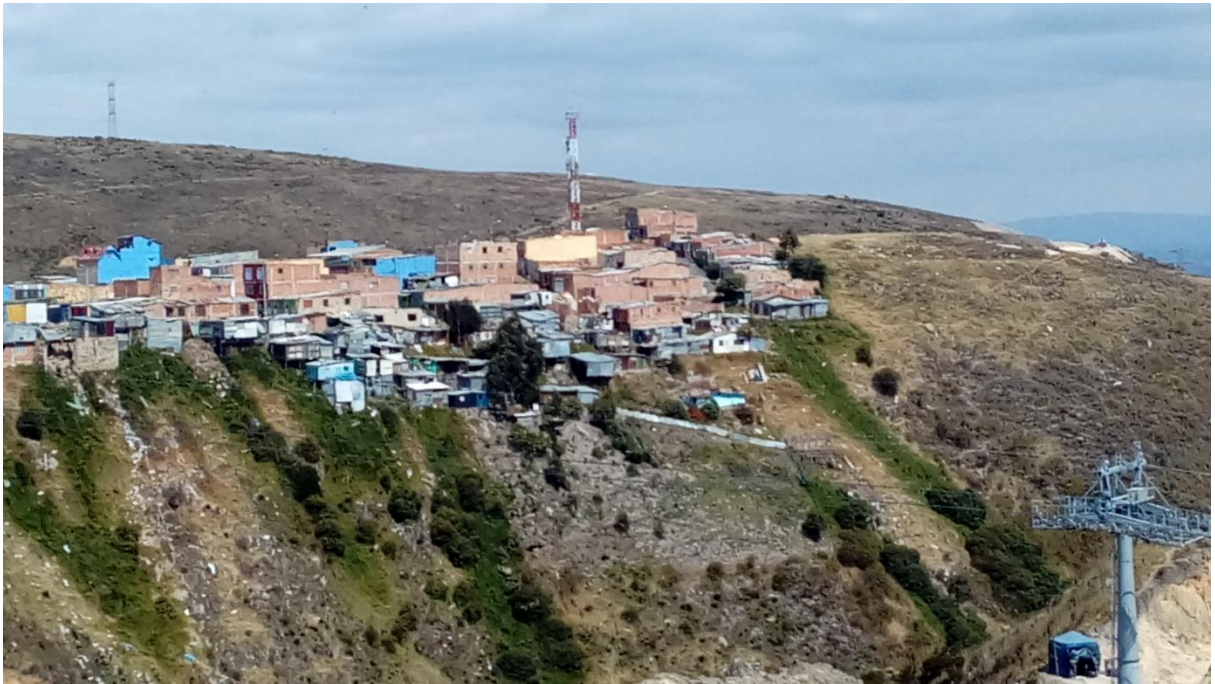
Imagen 6: Pilastras transmicable –zonas vulnerables (foto propia)
