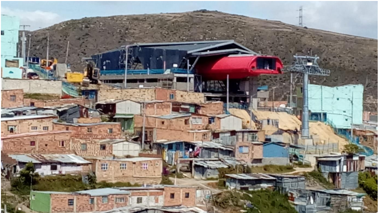
Imagen 8: Estación Illimani transmicable (foto propia)
