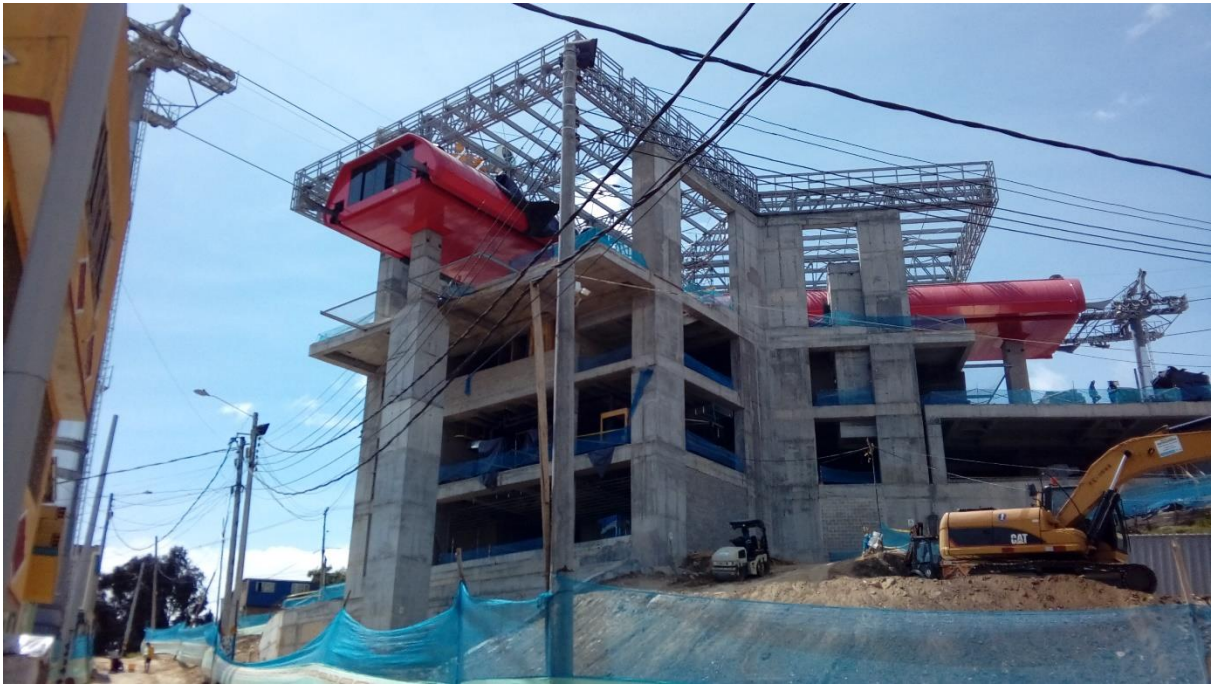
Imagen 12: Estación Manitas Transmicable (foto propia)
