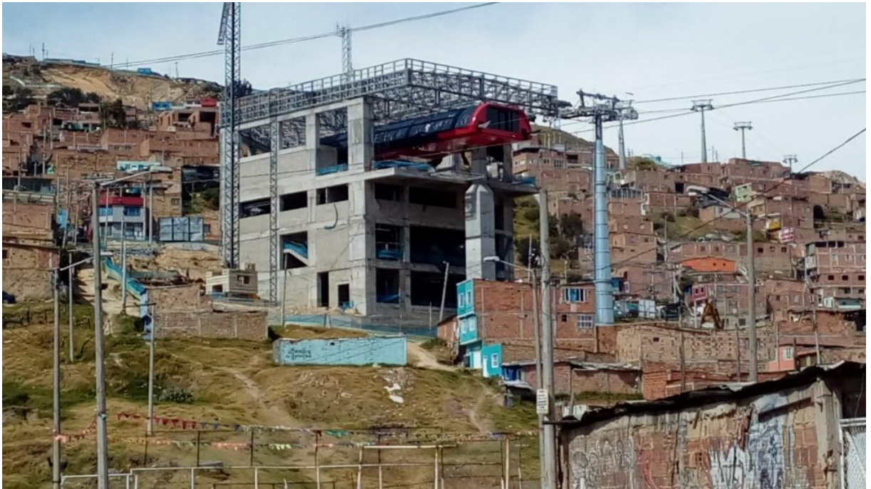
Imagen 4: Estación Manitas Transmicable (foto propia)
