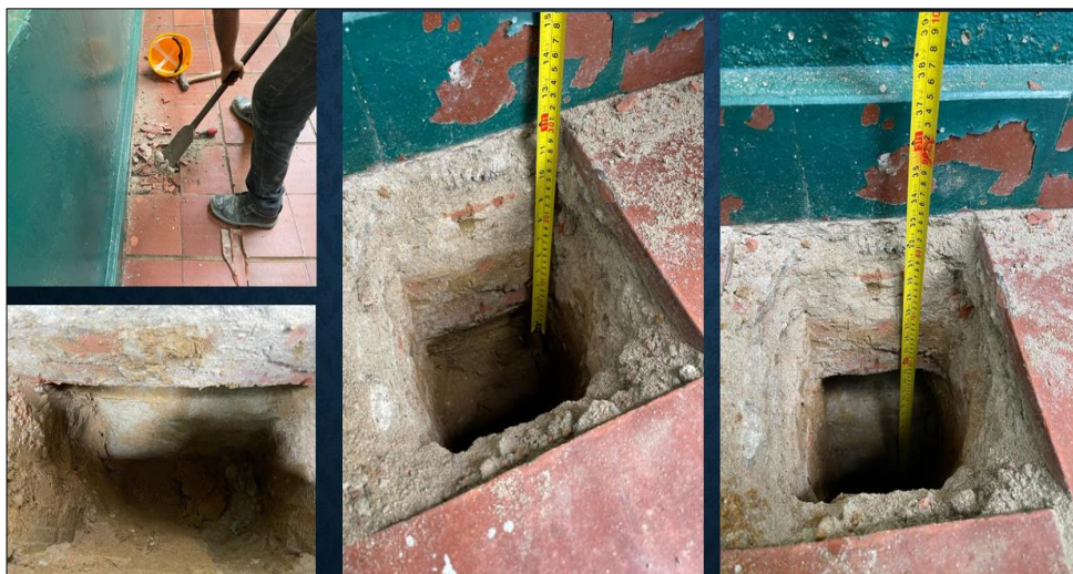
IMAGEN 18 tomada informe inspección visual ingeniero estructural
