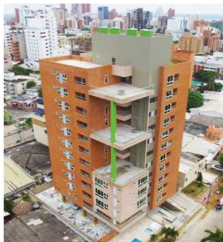
Imagen 12. Edificio Viverdi 85 Barranquilla. Fuente: CCCS
