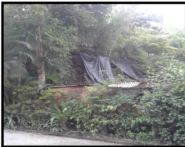
Imagen 14. Vivienda en zona de deslizamiento.
