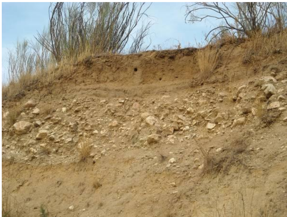
Figura 19. Talud erosionado.
