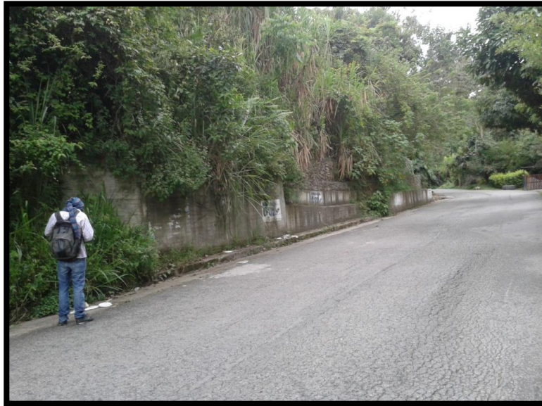
Imagen 16. Muro de contención y muro de gaviones.
