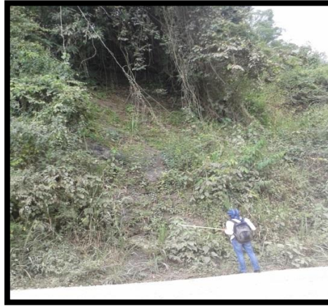
Imagen 6. Socavación y pérdida de capa vegetal.
