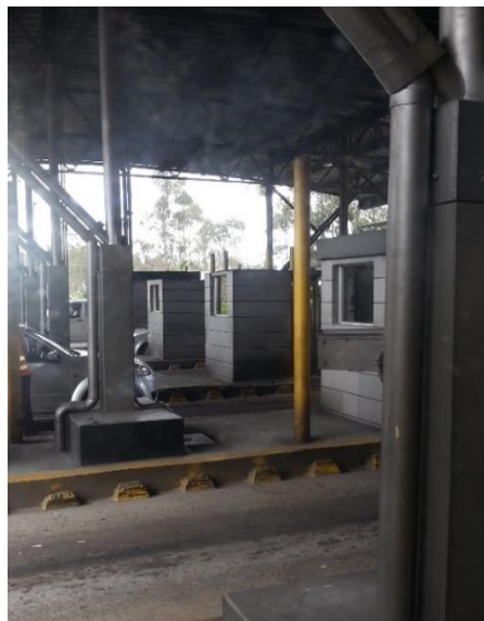
Figura 10. Casetas de cobro
