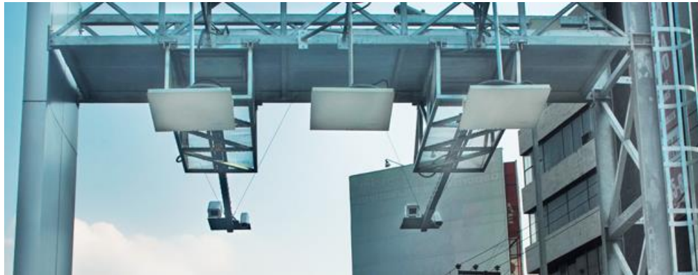
Figura 2. Pórtico sistema Free Flow
