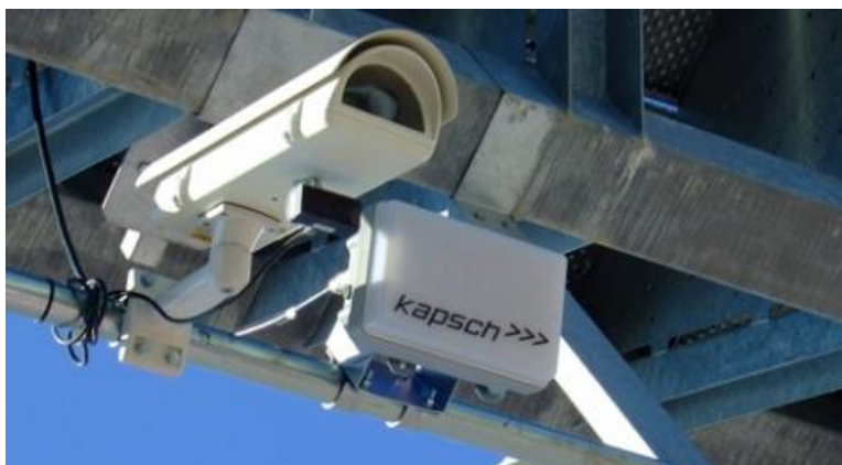
Figura 4. Cámaras de reconocimiento vehicular
