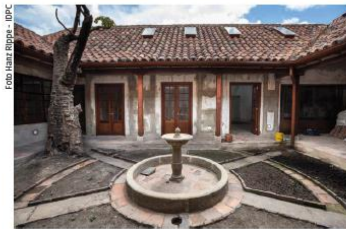
Obras de reforzamiento estructural y adecuación
