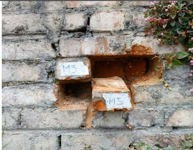
Ilustración 20. Muestra de mampostería extraída N°3.
