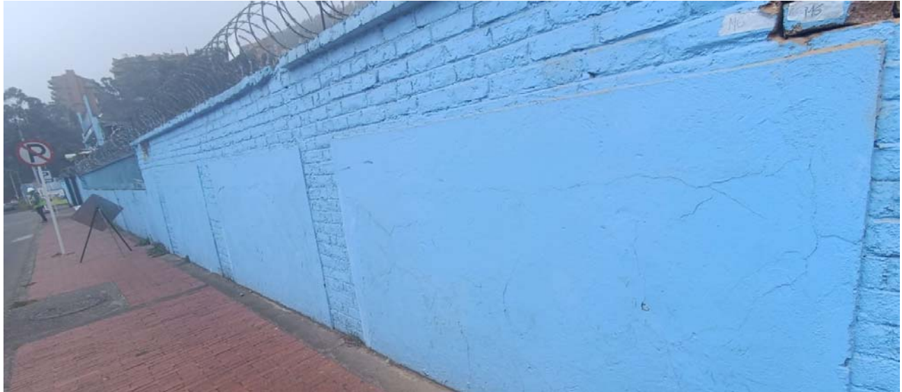
Ilustración 8. Panorámica estado actual Muro 3. (Fuente: Propia).
