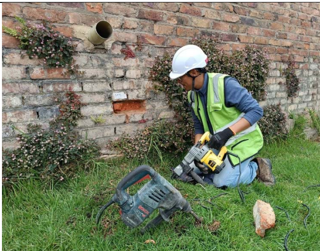
Ilustración 16. Proceso de extracción de muestra de mampostería.
