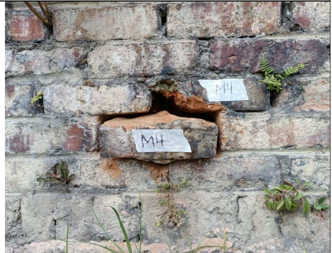
Ilustración 21. Muestra de mampostería extraída N°4.
