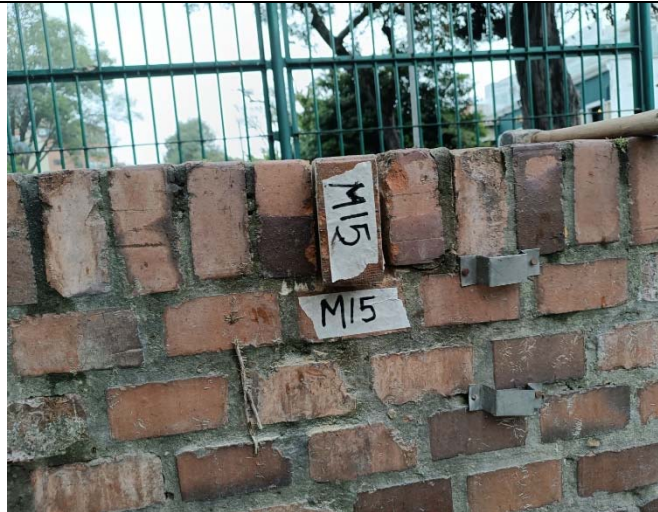
Ilustración 32. Muestra de mampostería extraída N°15.
