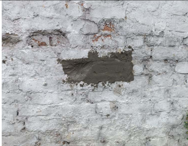
Ilustración 34. Resane de extracción.
