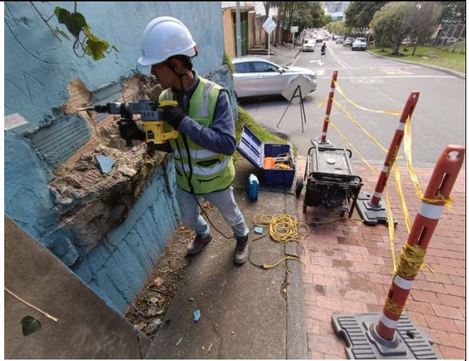
Ilustración 15. Proceso de extracción de muestra de mampostería.
