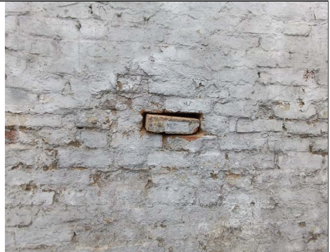
Ilustración 19. Muestra de mampostería extraída N°2.
