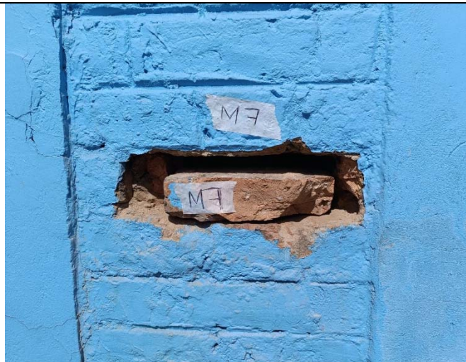
Ilustración 24. Muestra de mampostería extraída N°7.
