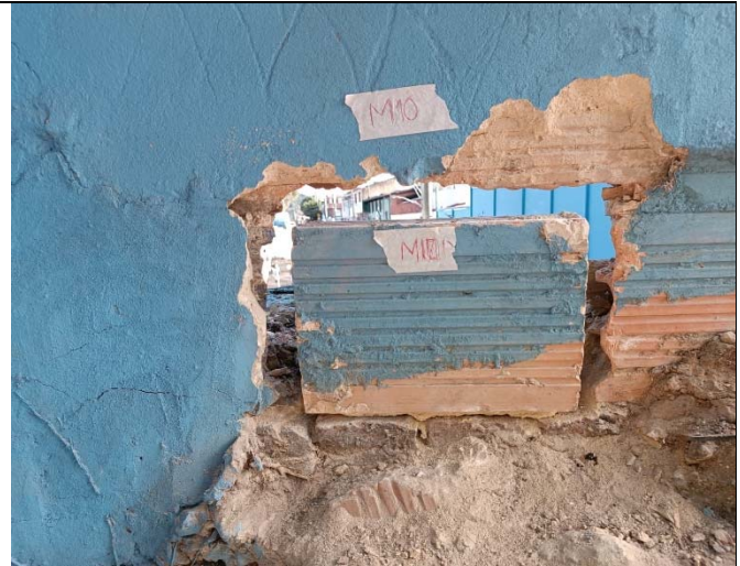
Ilustración 27. Muestra de mampostería extraída N°10.
