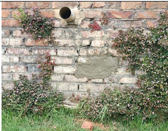
Ilustración 36. Resane de extracción.
