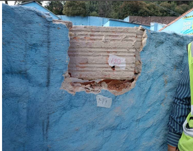
Ilustración 26. Muestra de mampostería extraída N°9.
