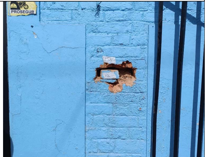
Ilustración 25. Muestra de mampostería extraída N°8.
