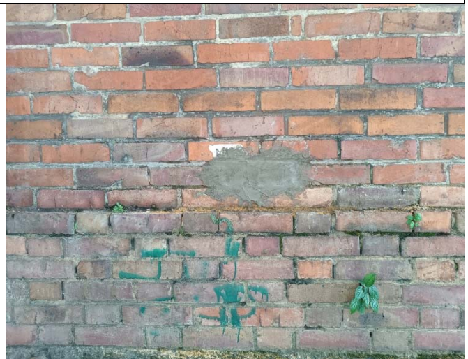
Ilustración 43. Resane de extracción.
