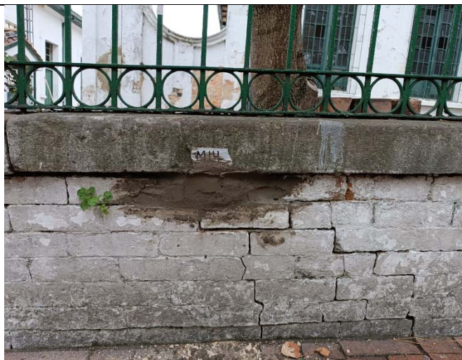
Ilustración 44. Resane de extracción.
