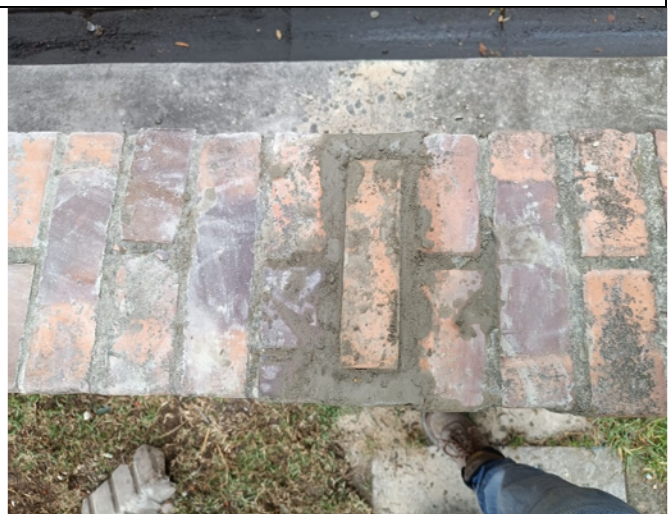
Ilustración 45. Resane de extracción.
