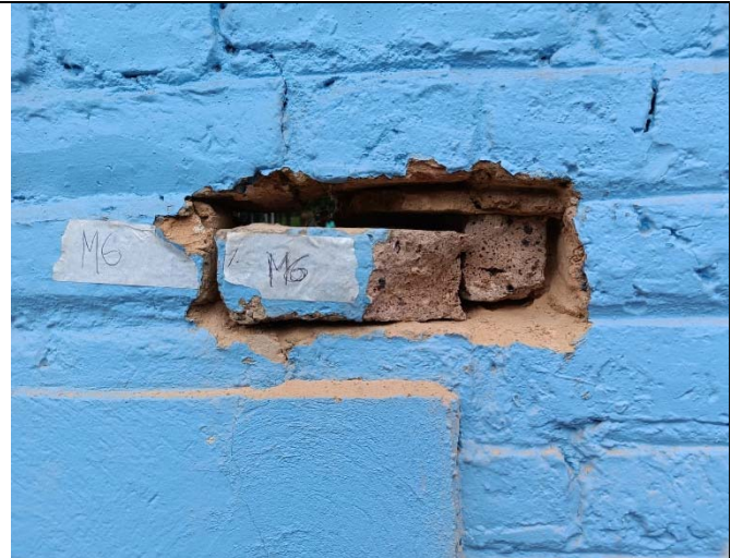
Ilustración 23. Muestra de mampostería extraída N°6.
