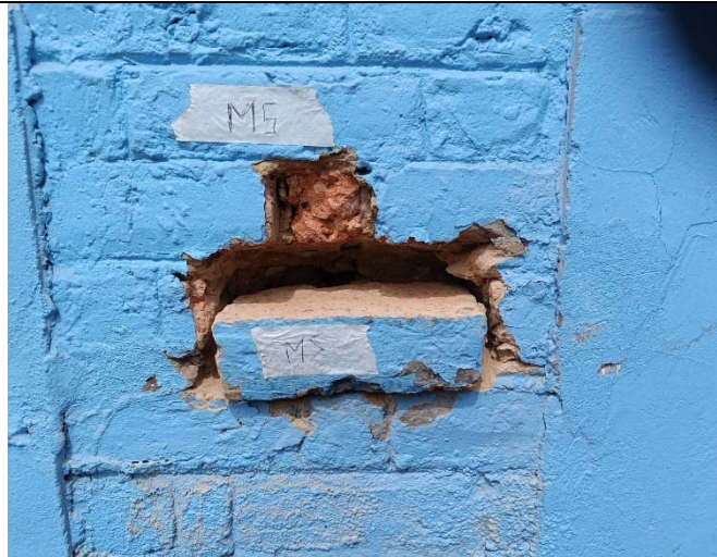
Ilustración 22. Muestra de mampostería extraída N°5.
