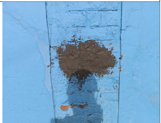
Ilustración 39. Resane de extracción.
