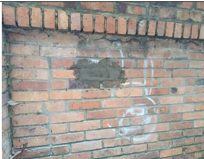
Ilustración 42. Resane de extracción.
