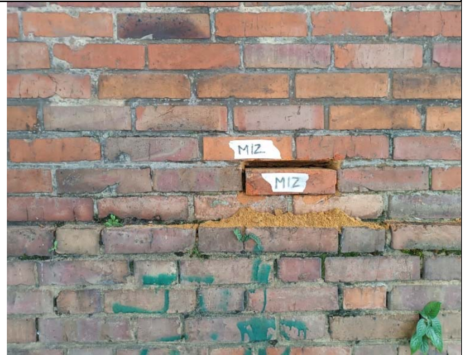
Ilustración 29. Muestra de mampostería extraída N°12.
