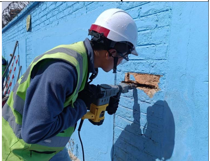
Ilustración 17. Proceso de extracción de muestra de mampostería.
