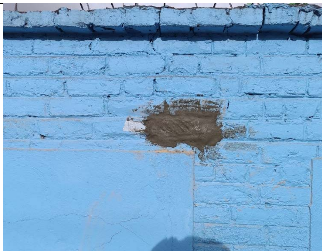
Ilustración 38. Resane de extracción.
