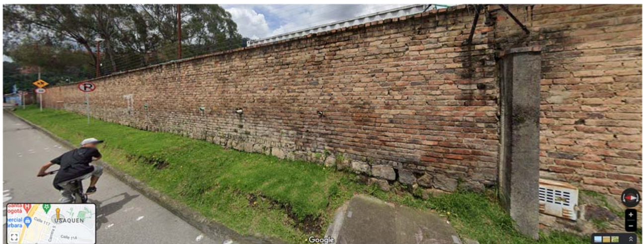
Ilustración 7. Panorámica estado actual Muro 2. (Fuente: Google Earth).
