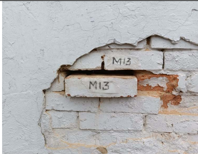
Ilustración 30. Muestra de mampostería extraída N°13.
