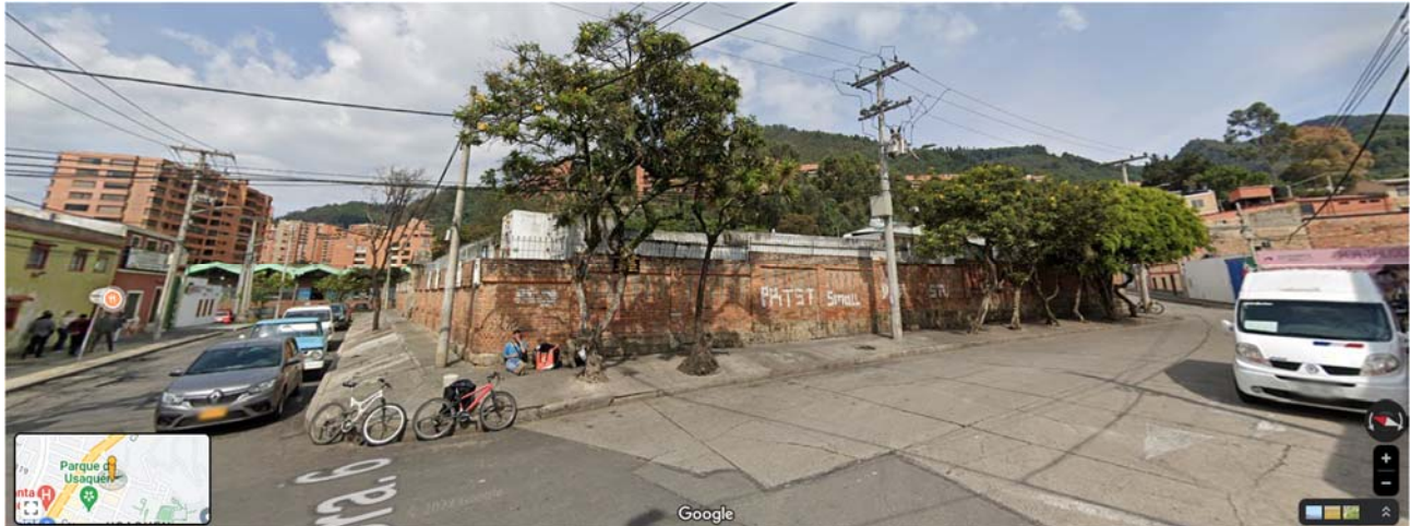
Ilustración 10. Panorámica estado actual Muro 5. (Fuente: Google Earth).
