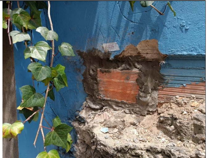
Ilustración 41. Resane de extracción.
