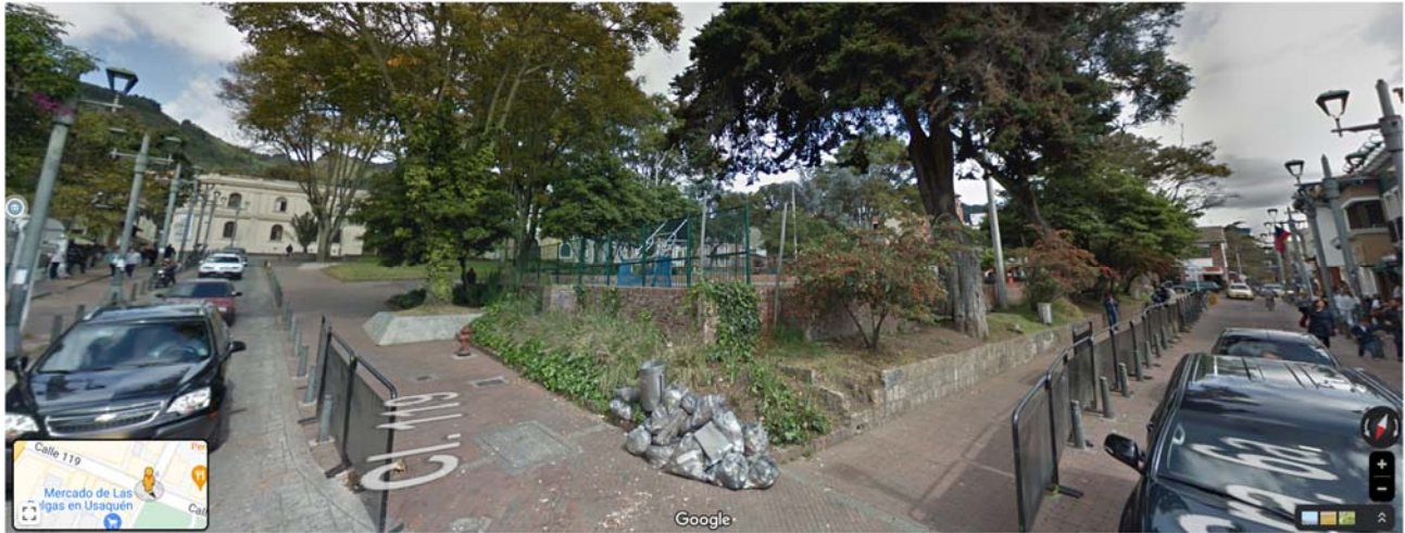
Ilustración 12. Panorámica estado actual Muro 7. (Fuente: Google Earth).
