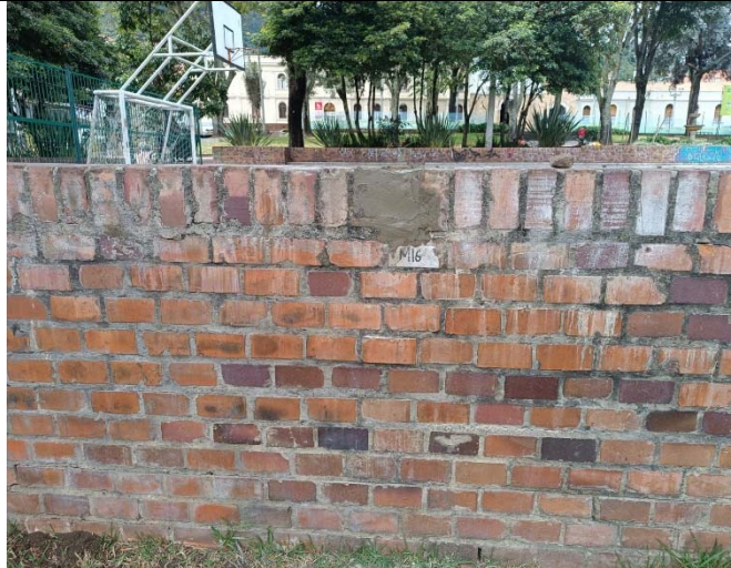
Ilustración 46. Resane de extracción.
