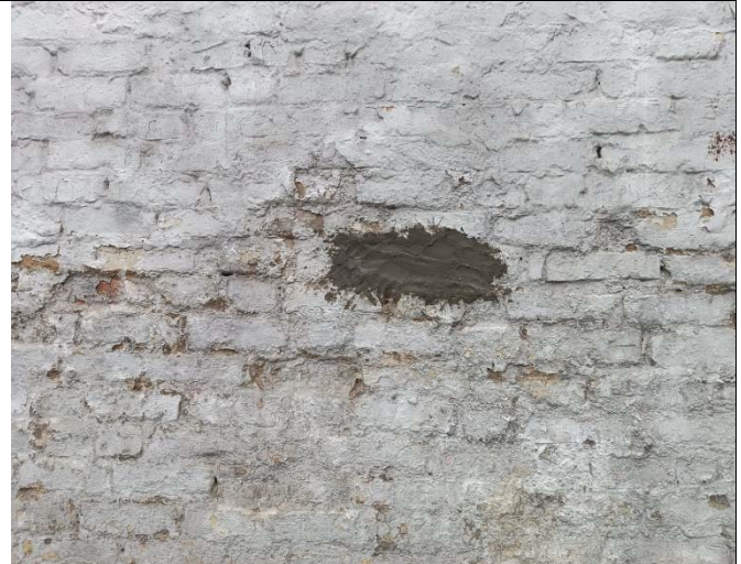
Ilustración 35. Resane de extracción.
