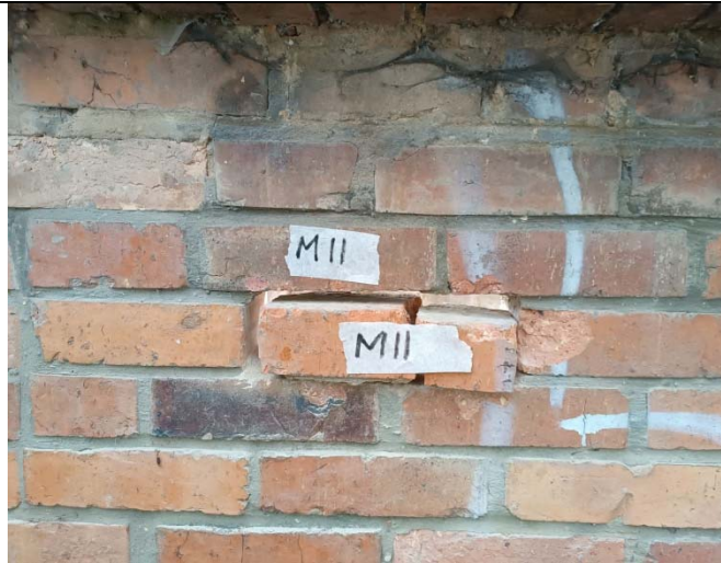
Ilustración 28. Muestra de mampostería extraída N°11.
