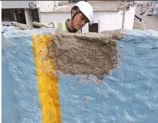
Ilustración 40. Resane de extracción.
