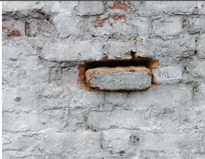
Ilustración 18. Muestra de mampostería extraída N°1.
