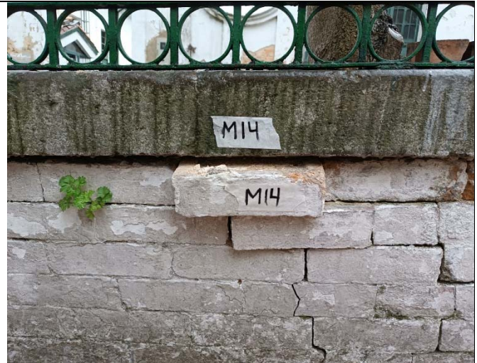
Ilustración 31. Muestra de mampostería extraída N°14.
