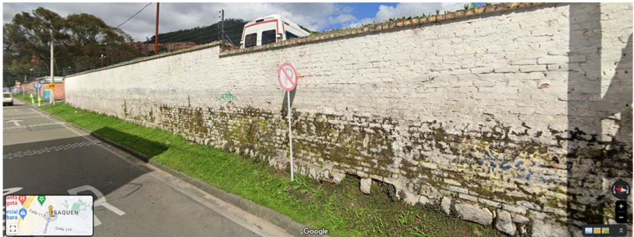
Ilustración 6. Panorámica estado actual Muro 1. (Fuente: Google Earth).
