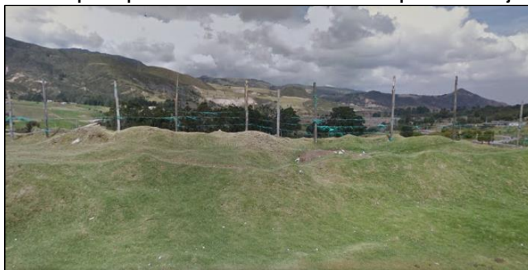
Foto N° 2 Lote que requiere adecuación de re nivelación para el montaje de aulas
