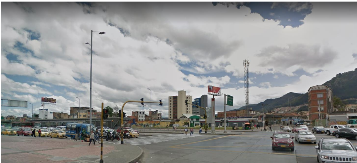
Figura 25 Situación actual del lugar de intervención
