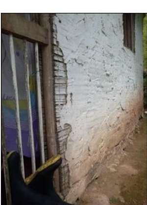
Ilustración 19 Bahareque encementado sin o con malla "real"
