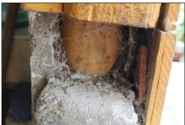
Ilustración 19 Bahareque encementado sin o con malla "real"
