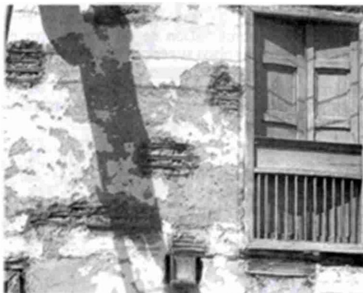
Ilustración 3 Muro en bahareque encementado
