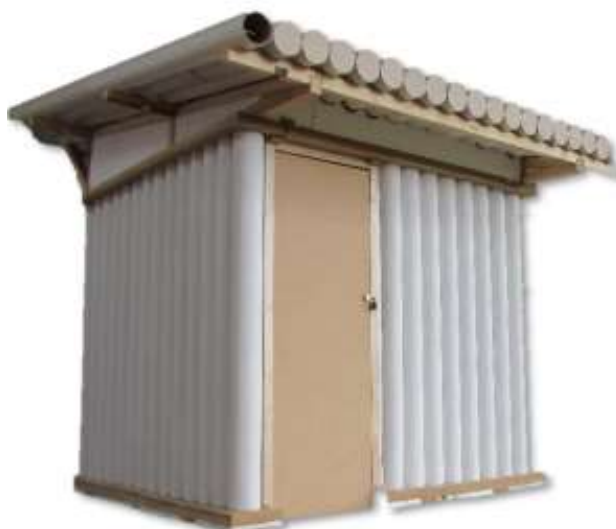
Figura 5. Prototipo constructivo del uso de cartón tubular rellenos de aserrín, para la conformación de muros. el proceso de impermeabilización los tubos, demostró la eficiencia del producto marca Corona, ya que, al someterlo a la prueba, absorbió el 1% de agua, en comparación con el imprímato el cual absorbió un 22%. Demostrando de esta manera la durabilidad de los elementos frente a agentes externos como la lluvia en fachadas de uso residencial. Tomada de: Fernández y Hernández (2016). Muros en tubos de cartón rellenos se aserrín como aislantes térmicos para climas fríos (Tesis de tecnología). Universidad la Gran Colombia, Bogotá D.C. Recuperado de https://repository.ugc.edu.co/bitstream/handle/11396/4020/Proyecto%20Muros%20en%20Tubos%20de%20Carton%20Rellenos%20de%20Aserr%c3%adn.pdf?sequence=1&isAllowed=y .
