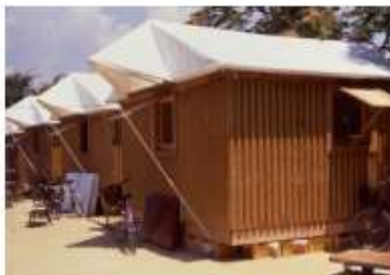
Figura 6. Refugio construido en el terremoto de Kobe (Japón). Tomada de: Pérez Gamarra, S. (2015). Construcción alternativa III. contricción low-cost reciclar y construir con el desecho otras oportunidades para materiales de reciclado y nuevos usos para los materiales convencionales. Universidad de Valladolid, Valladolid. Recuperado de http://uvadoc.uva.es/handle/10324/14068 .
