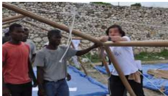
Figura 10. Shigeru Ban enseñando a armar una estructura en cartón tubular. Tomado de: Blixt. (2019). Total safe pack. Recuperado de https://www.totalsafepack.com/arquitectura-sostenible-con-carton-reciclado/
