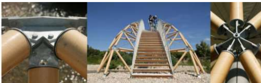
Figura 13. Unión rígida de acero en Pasarela Temporal y Pabellón Vasarely Tomado de: Huaroto, A. (2018). Investigación previa acerca del empleo de tubos de cartón reciclado (paperboard tubes/ paperboard cores) en edificaciones (tesis de pregrado). Universidad Peruana de Ciencias Aplicadas (UPC), Huancayo. Recuperado de https://www.researchgate.net/publication/324982924_INVESTIGACION_PREVIA_ACERCA_DEL_EMPL_EO_DE_TUBOS_DE_CARTON_RECICLADO_PAPERBOARD_TUBES_PAPERBOARD_CORES_EN_EDIFICACIONES
