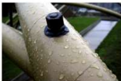
Figura 12. Tubos de cartón aislados frente a la humedad mediante doble tratamiento. Tomado de: Huaroto, A. (2018). Investigación previa acerca del empleo de tubos de cartón reciclado (paperboard tubes/ paperboard cores) en edificaciones (tesis de pregrado). Universidad Peruana de Ciencias Aplicadas (UPC), Huancayo. Recuperado de https://www.researchgate.net/publication/324982924_INVESTIGACION_PREVIA_ACERCA_DEL_EMPL_EO_DE_TUBOS_DE_CARTON_RECICLADO_PAPERBOARD_TUBES_PAPERBOARD_CORES_EN_EDIFICACIONES
