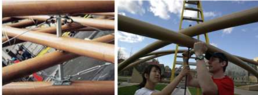
Figura 18. Uniones o conexiones superpuestas, que se atornillaron a través de los tubos.
