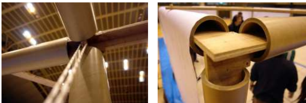
Figura 11. Detalle de la unión de los cilindros de cartón y refuerzo de cuerda con una pieza de contrachapado. En Fujisawa por Shigeru en el 2006.
