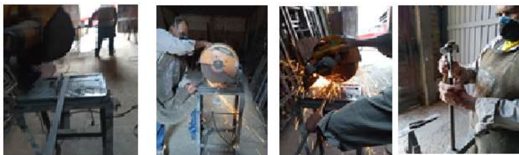
Figura 29. Proceso de modelamiento de las piezas en acero.
