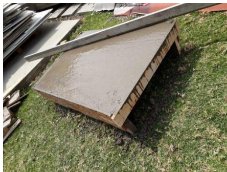
Ilustración 39: Entrepiso esterilla de guadua totalmente fundido
