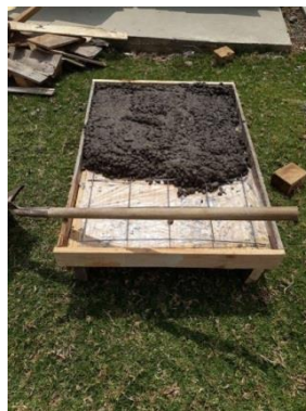
Ilustración 38: Vertimiento del concreto para sistema de entrepiso esterilla de guadua
