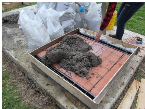
Ilustración 28: Vertimiento del concreto para placa fácil
