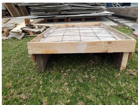
Ilustración 34: Esterilla de guadua sobre perfiles en madera
