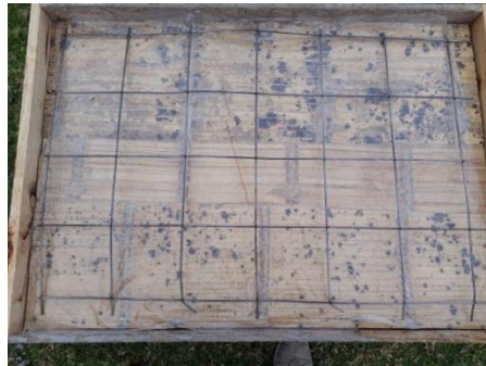
Ilustración 37: Malla electro soldada lista para fundir concreto
