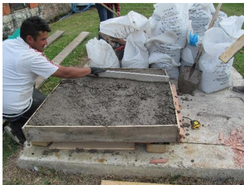
Ilustración 29: Nivelación del concreto para placa fácil
