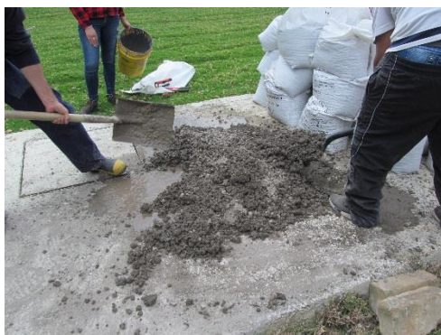
Ilustración 27: Preparación de concreto de 3000 psi
