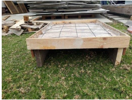
Ilustración 36: Colocación malla electro soldada sobre esterilla de guadua
