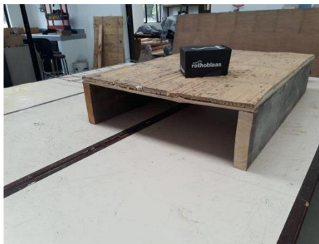
Ilustración 33: Colocación de perfiles en madera
