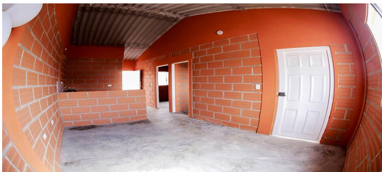
Figura 2 Interior vivienda interés social. La ilustración muestra el interior de una de las viviendas entregadas a las familias pobres en Colombia, este es uno de los modelos más comunes en las zonas urbanas para este tipo de viviendas, Tomado de “Gobierno entrega 179 casas gratis en Turbaco, Bolívar”, Tomas Betín (2017). Recuperado de https://www.elheraldo.co/bolivar/gobierno-entrega-179-casas-gratis-en-turbaco-bolivar-427666
