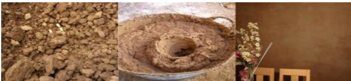
Figura 25 Revoque interno en tierra. La ilustración expone el proceso de un revoque en barro, Tomado de “Acabados y revestimientos en el diseño de arquitectura en tierra Blanca” Buzzano (2017). Recuperado de: http://www.fadu.edu.uy/tesinas/files/2018/08/TESINA_ACABADOS-Y-REVESTIMIENTOS-EN-EL-DISE%C3%91O-DE-ARQUITECTURA-DE-TIERRA_Bozzano-Blanca-FINAL.pdf
