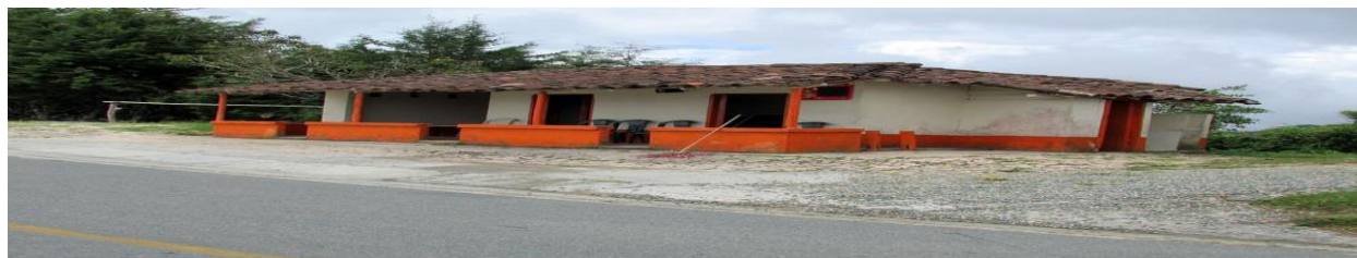
Figura 4 Vivienda rural Antioquia. La ilustración muestra una casa rural común ubicada en Colombia de las cuales no fueron entregadas por el gobierno y fueron construidas con pocos conocimientos por lo cual sus terminaciones son muy rusticas y simples sin gran protección ante la intemperie, Tomado de “vivienda rural santo domingo Antioquia”, Dairo Correa ( 2013). Recuperado de: https://www.flickr.com/photos/dairocorrea/10423096895
