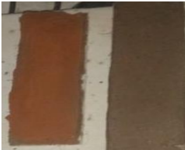
Figura 28 Prototipo pañete externo a base de tierra. La ilustración muestra el resultado final del proceso aplicado. Elaboración propia.
