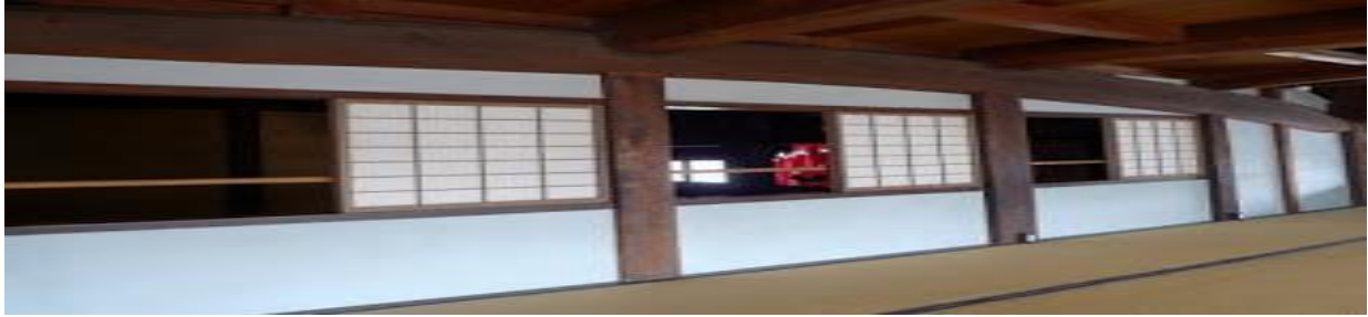
Figura 16 Casa tradicional japonesa. La ilustración muestra una vivienda tradicional japonesa en su interior, evidenciando el uso de la tierra como acabado final, sutil, estético y duradero, Tomado de “Interior and Exterior finishes”, Kiwado (2015). Recuperado de: https://www.japaneseplastering.com/aboutus
