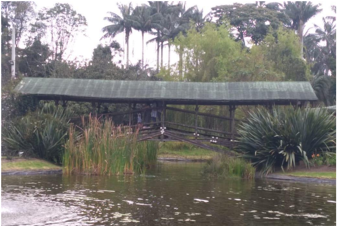
figura 35 costado este del puente de guadua
