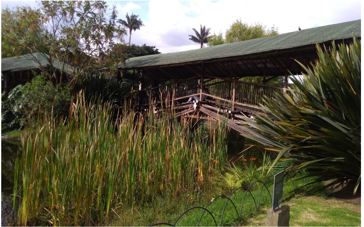
anexo 4 fotografía puente guadua (hora 3pm) validación de impacto solar, de norte a sur
