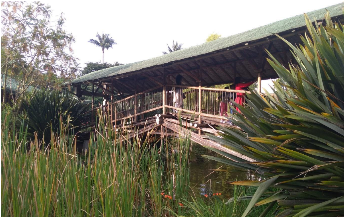
anexo 5 fotografía puente guadua (hora 4pm) validación de impacto solar, de norte a sur
