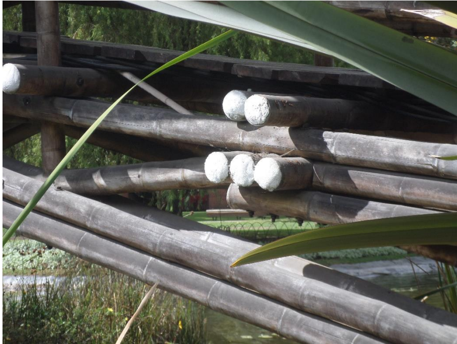
Figura 17 Lado transversal del puente
