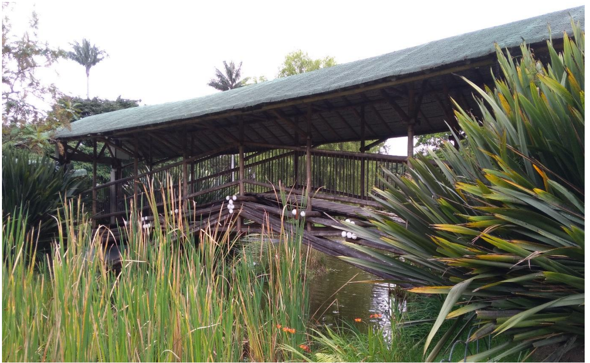
anexo 2 fotografía puente guadua (hora 9 am) validación de impacto solar
