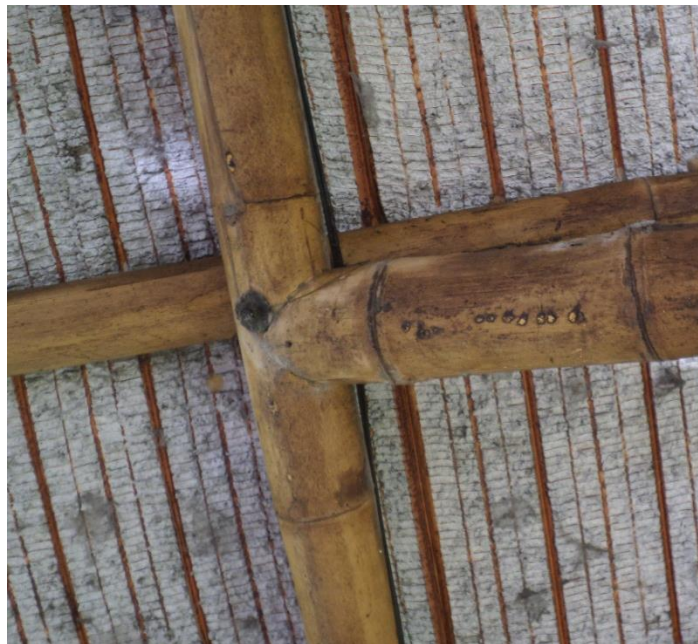
Figura 12 encuadre de unión sin elementos conectores
