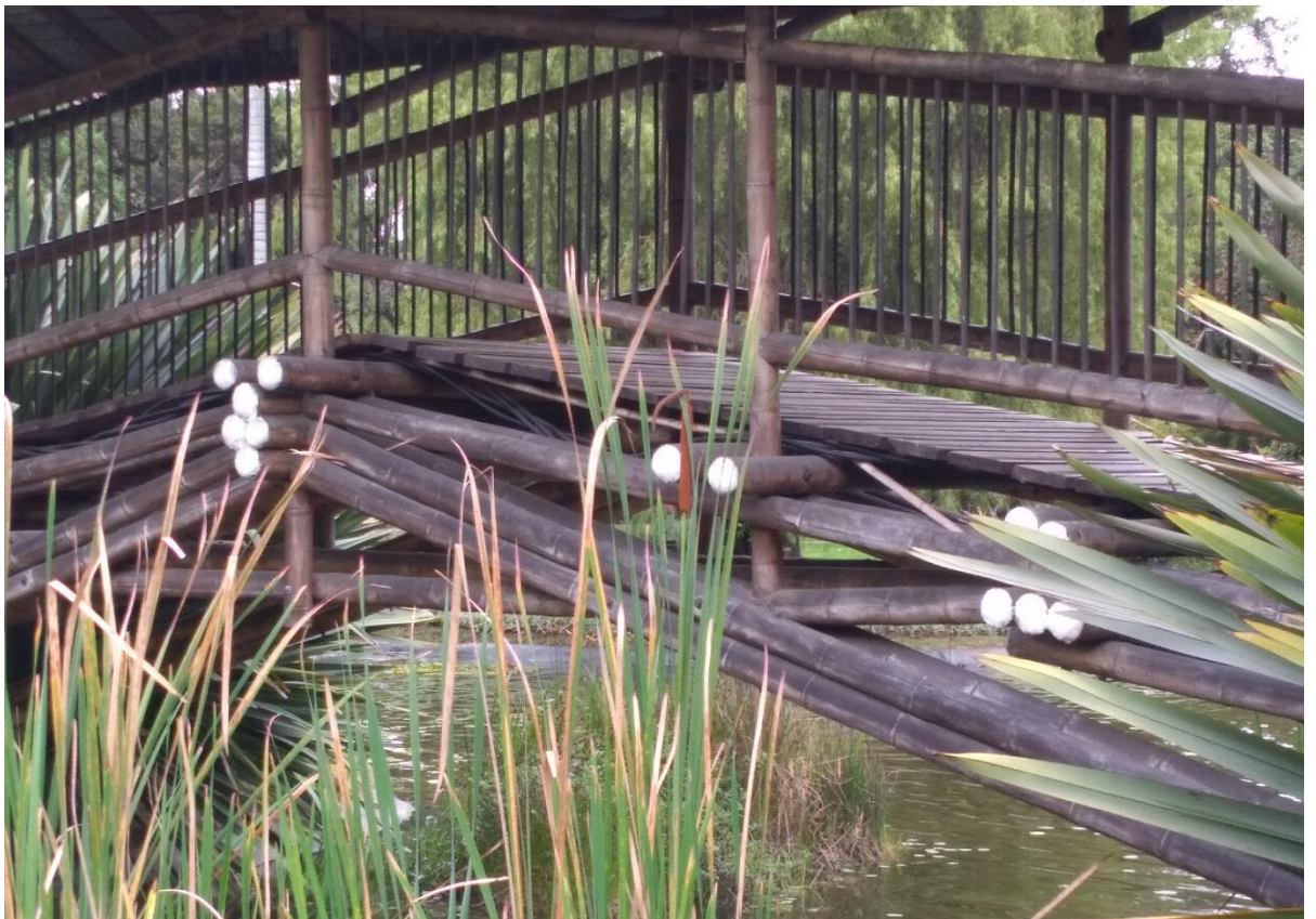
anexo 3 fotografía puente guadua (hora 10 am) validación de impacto solar
