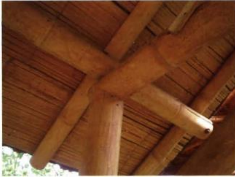
Figura 13 Unión con biselo boca de pescado (Foto. Eugenia González C. 2009) Fuente: (Osorio Saraz, González Castrillón, & Cortés Marín, 2010)
