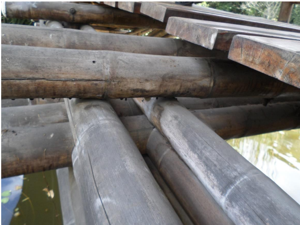
Figura 18 encuadre detalle de base en guadua foto degradada
