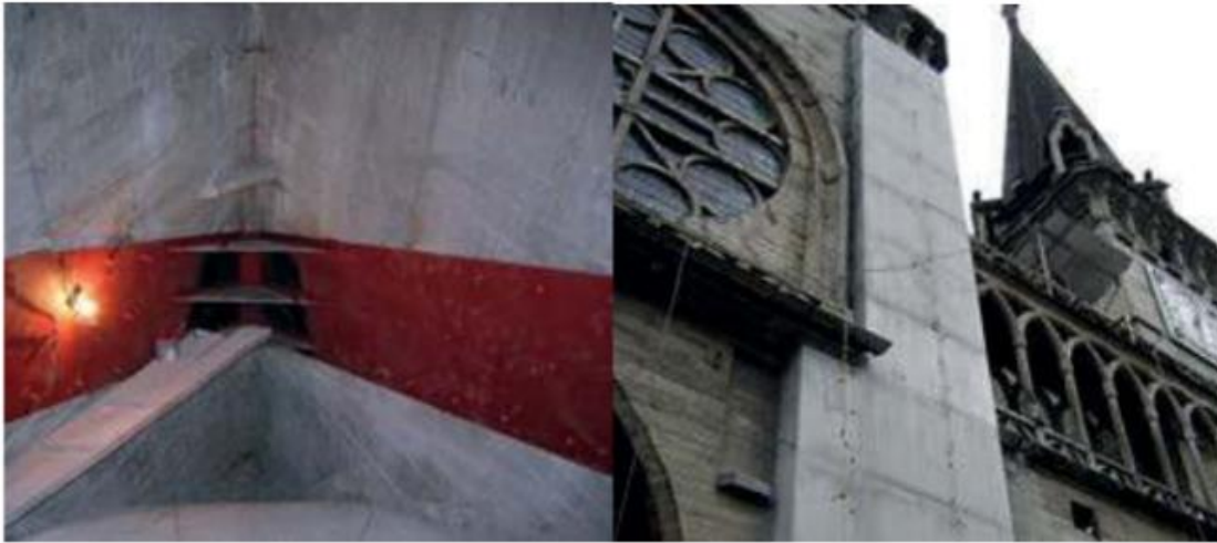
Figura 24 Vigas de acero.
