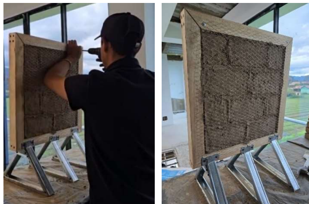
Figura 33 Colocación de malla
