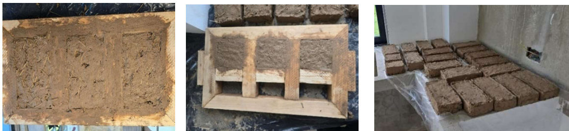
Figura 17 Vaciado de mezclas
