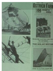
Ilustración 15 Instalación en Pasadena
