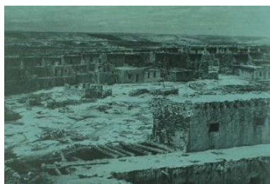
Ilustración 22 Vista general de Acoma.
