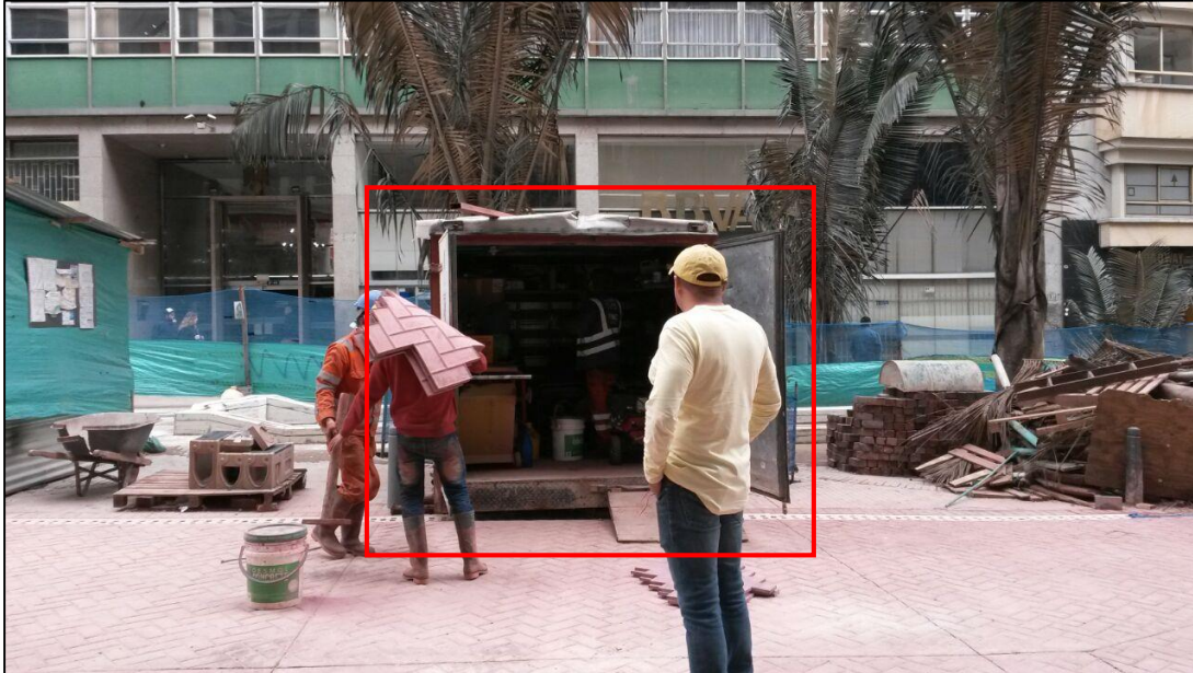
Figura 7 Campamento tipo container para material de obra, Cl. 7-13 Jiménez.
