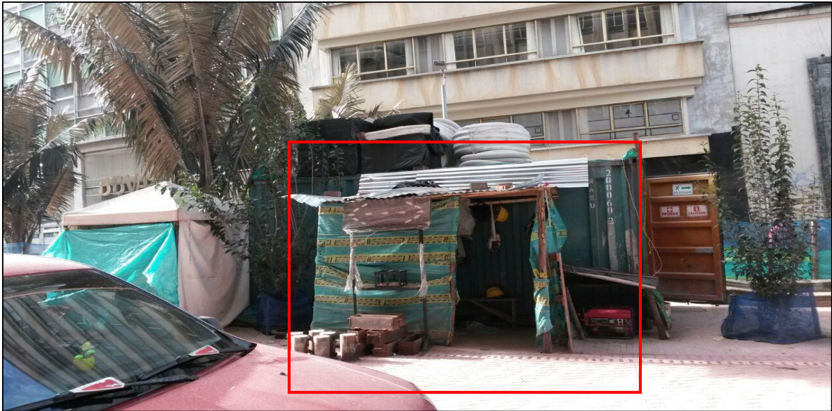
Figura 3 Campamento construido en poli-sombra verde y teja de zinc, Avenida Jiménez – Cr. 8a
