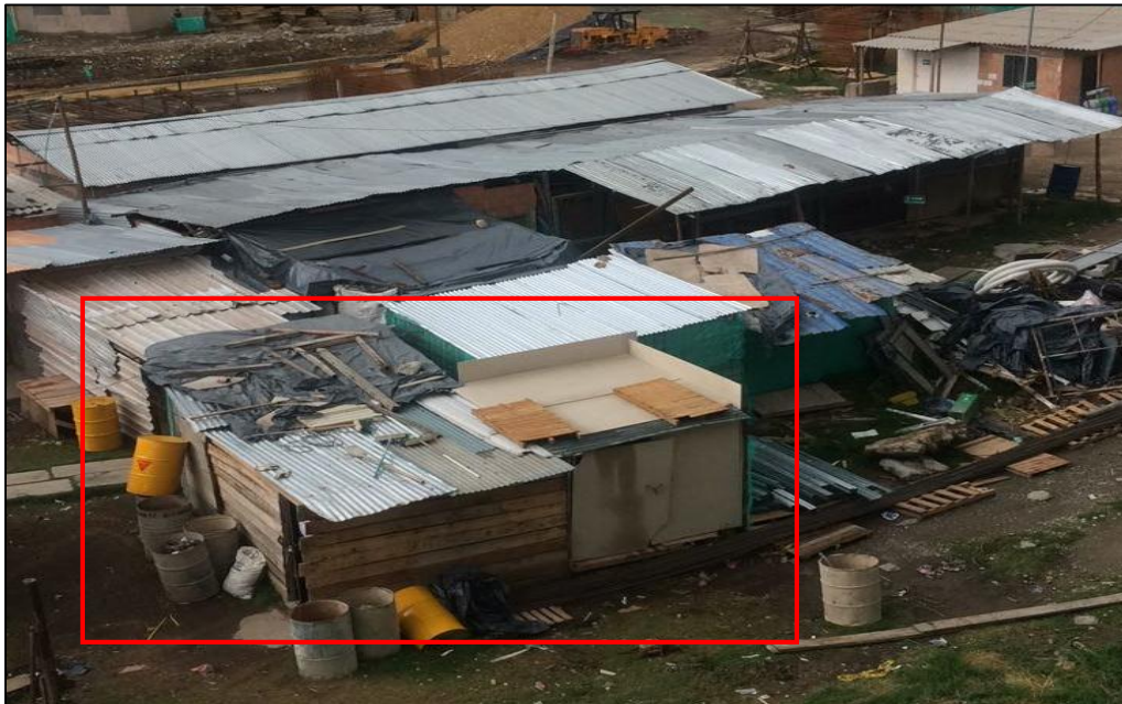
Figura 4 Campamento construido en madera, Suba Campiña Cl. 150 A # 96 A - 71
