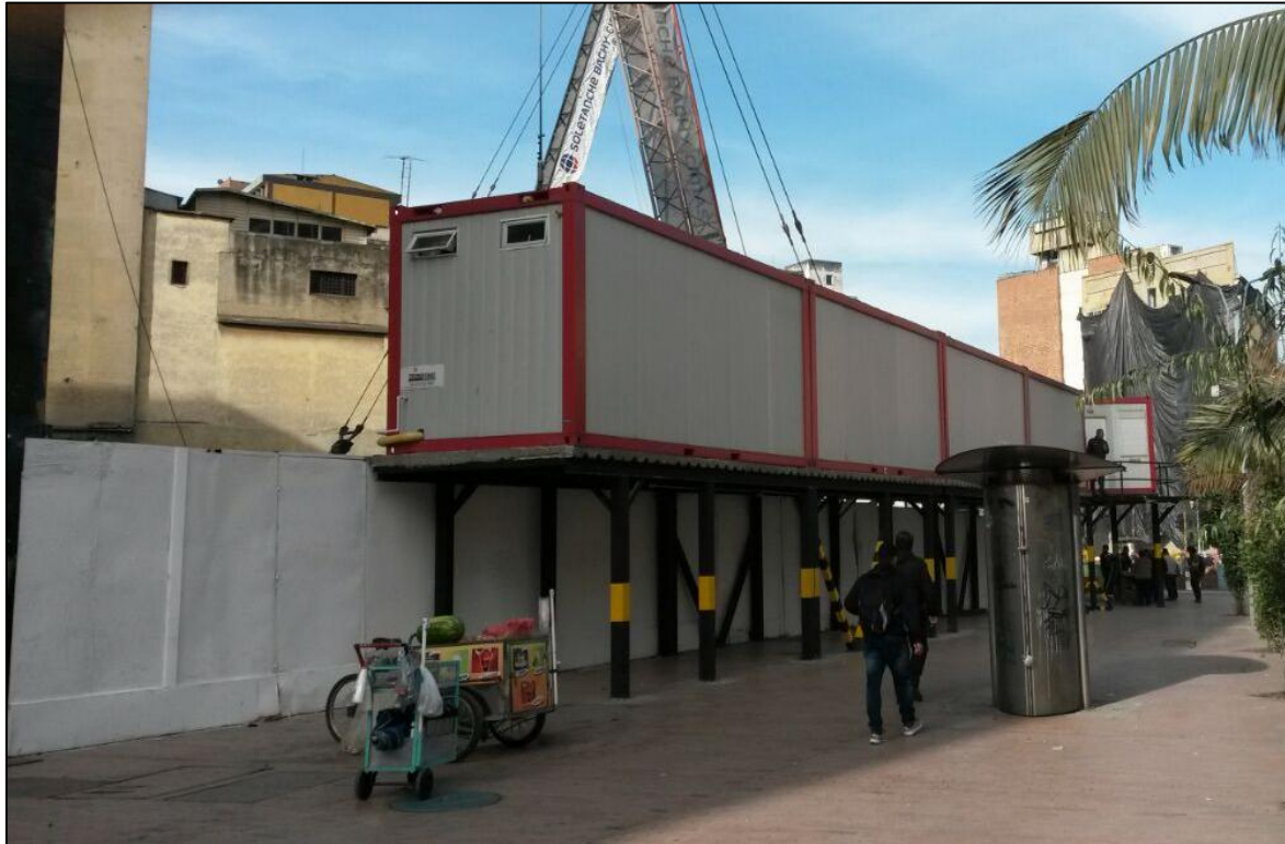
Figura 8 Campamento tipo container para oficinas, Cr 10 – Av. Jiménez.
