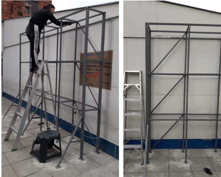
Figura 37. Aplicando la segunda capa de pintura anticorrosiva Fuente: elaboración propia (Ver Anexo 3. Planimetría Rain Wall, Plano A00)
