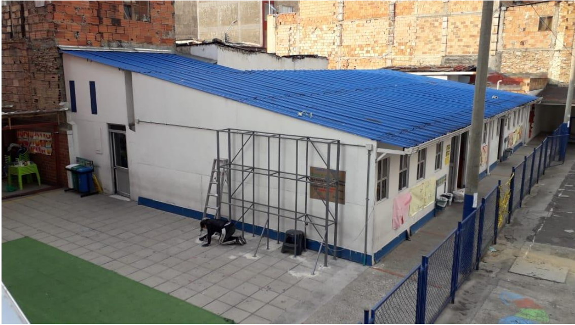
Figura 35. Vista aérea de la estructura general Fuente: elaboración propia (Ver Anexo 3. Planimetría Rain Wall, Plano A00)
