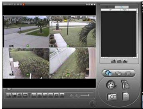
Ilustración 12. Sistema de Seguridad
