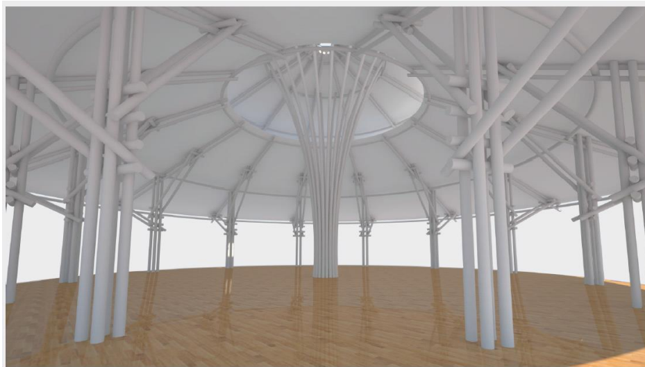
Ilustración 26: Estructura Maloka en guadua. 2014
